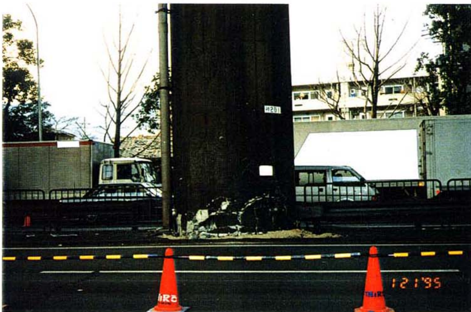
写真4.2.8 P201 ランク B (根元部破壊, 曲り)
