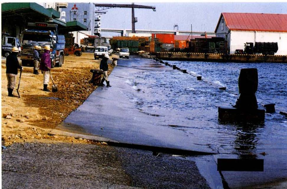
神戸港第2突堤～第3突堤間の岸壁のせりだしとそれに伴う沈下
