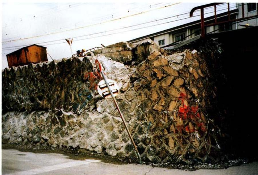
東灘区JR住吉駅付近の石積み擁壁（震度7～超震度7で法肩の陥没や壁面にクラック発生）
