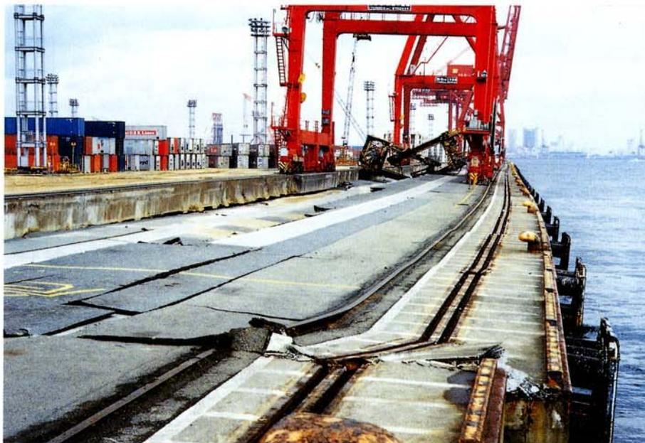
護岸のせりだしとクレーンの傾斜
