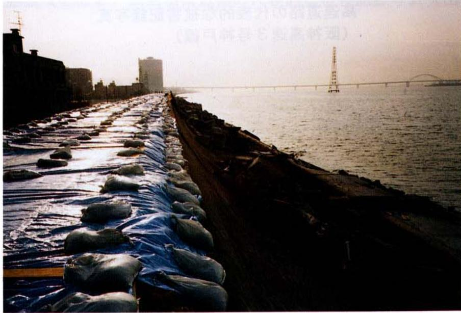
左岸堤防の沈下と側方変形
