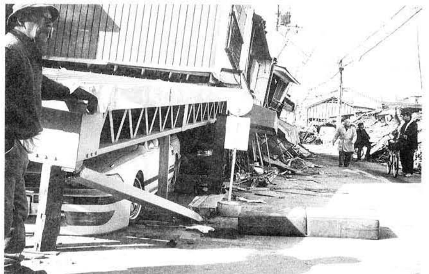
▲屋根が手の届く高さまで崩れている
