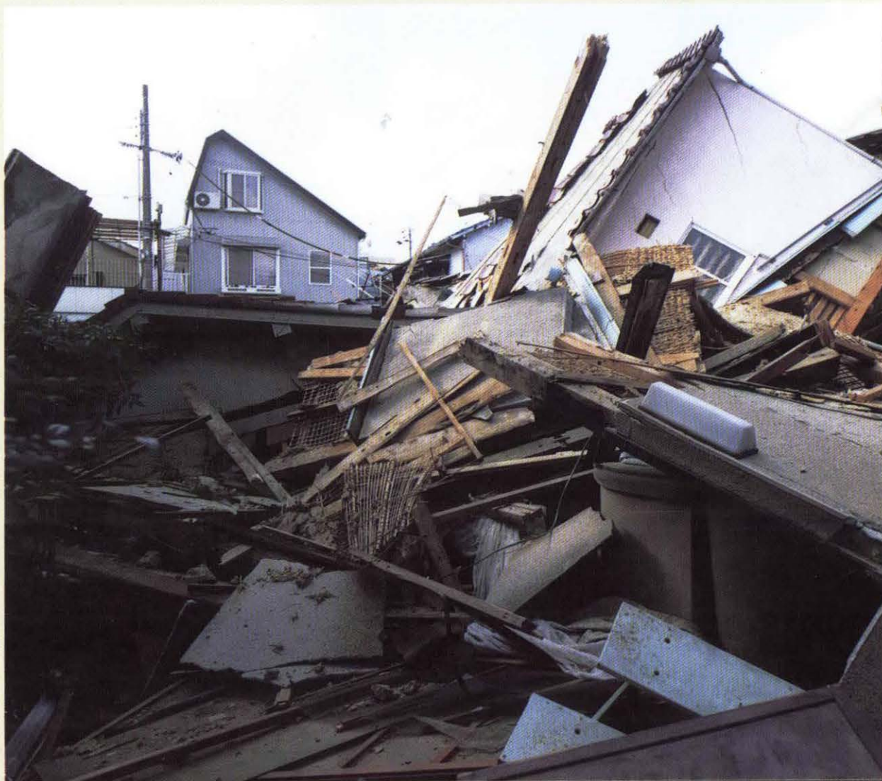
倒壊をまぬがれた住宅▲
