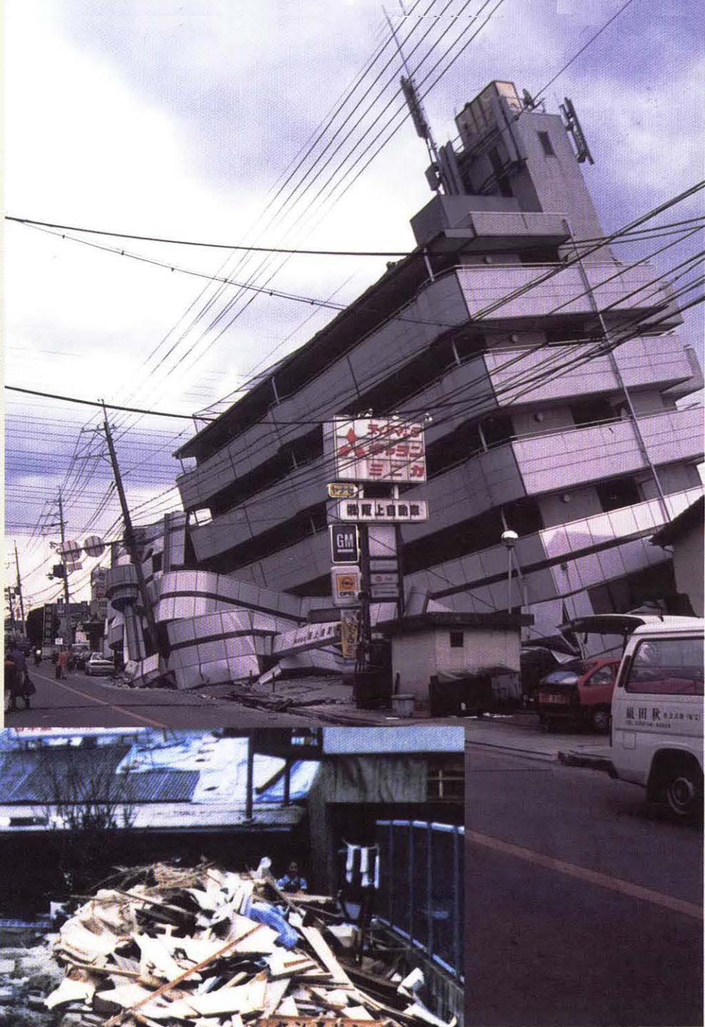
1・2階部分が崩れ傾いたビル▶
