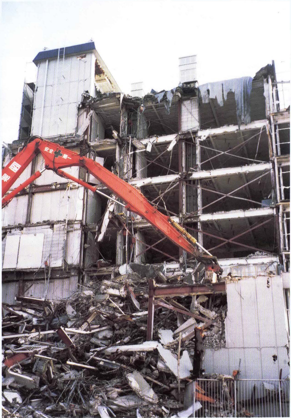
▲全壊し解体中の7階建マンション
