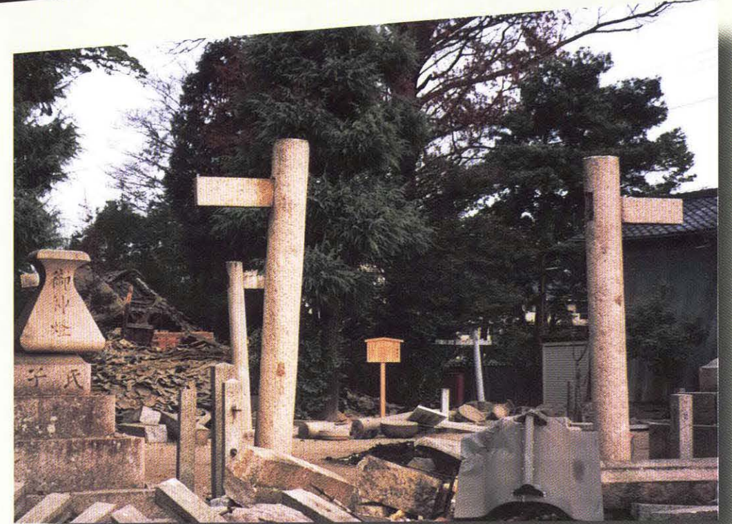
▲倒壊した国の重要文化財中筋八幡神社
