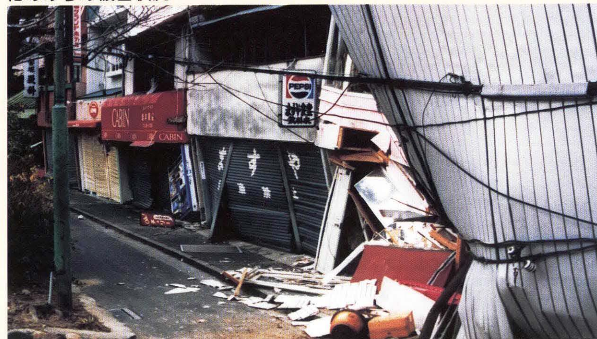
花のみちの被害状況▼
