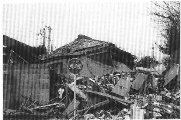
川面地区、家屋の被害
