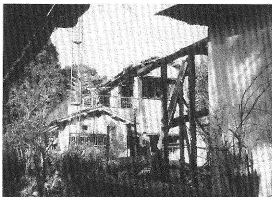
火災により全焼した家屋
