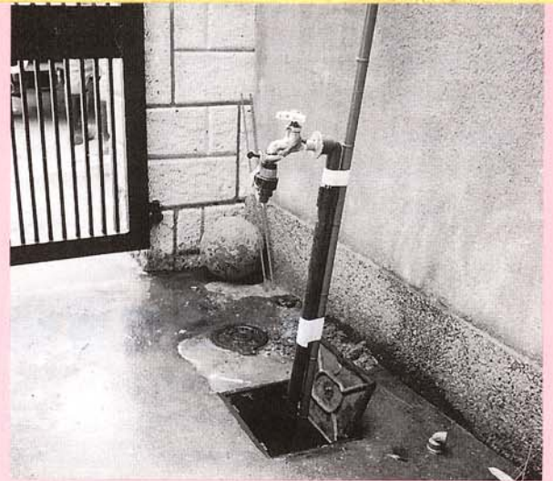
〈仮給水栓の設置状況〉
