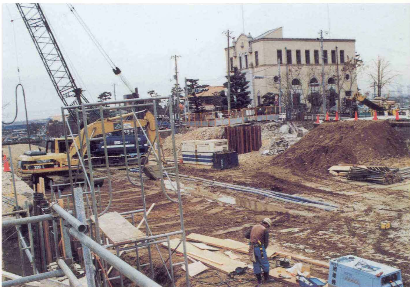
芦屋川左岸JR跨線橋
