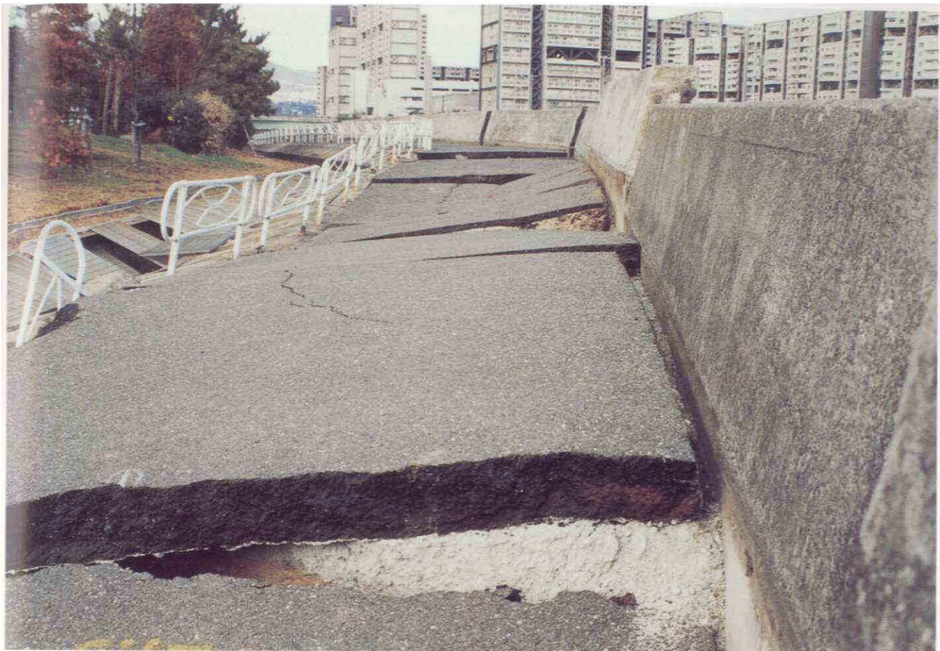
芦屋浜防潮堤付近
