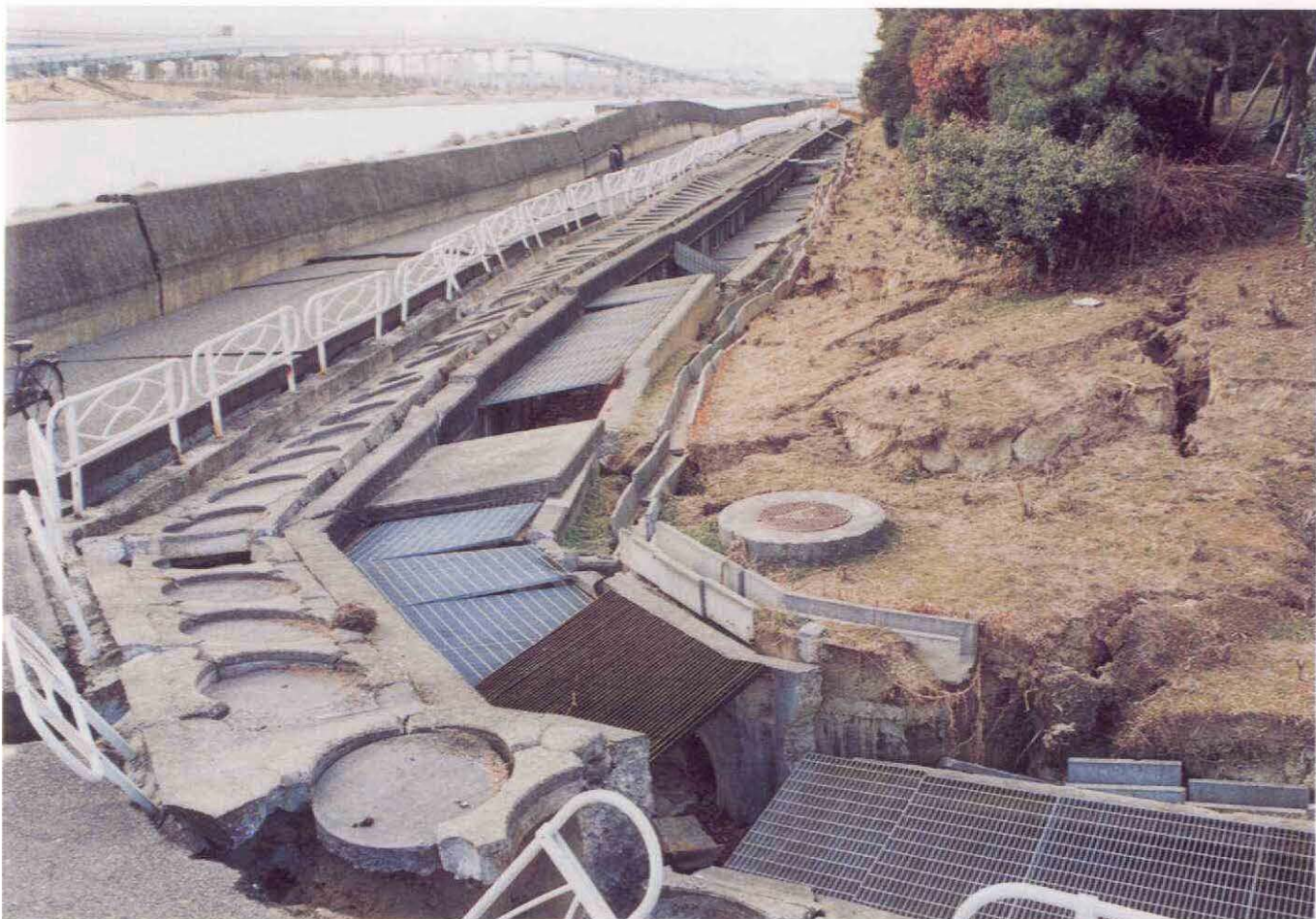
若葉町6番（芦屋浜）防潮堤宮川河口付近から西方面（H7. 2. 21撮影）
