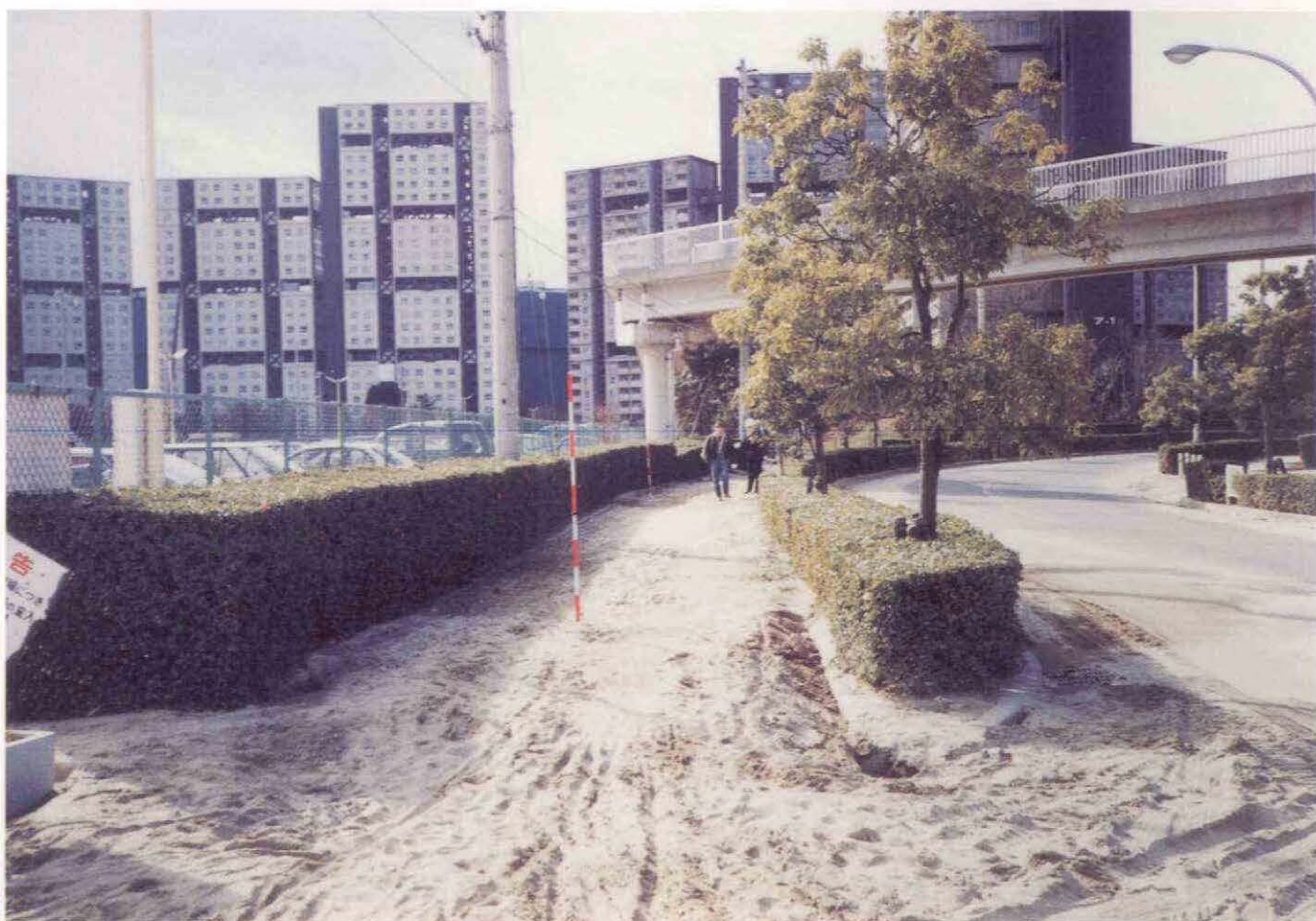
高浜町の道路状況 (H7. 2. 21撮影)
