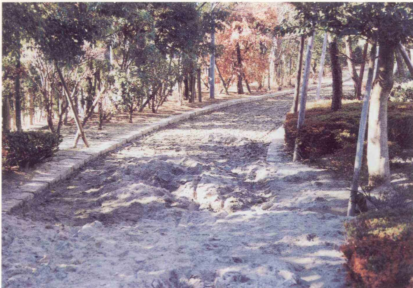
潮見町西浜公園内の液状化
