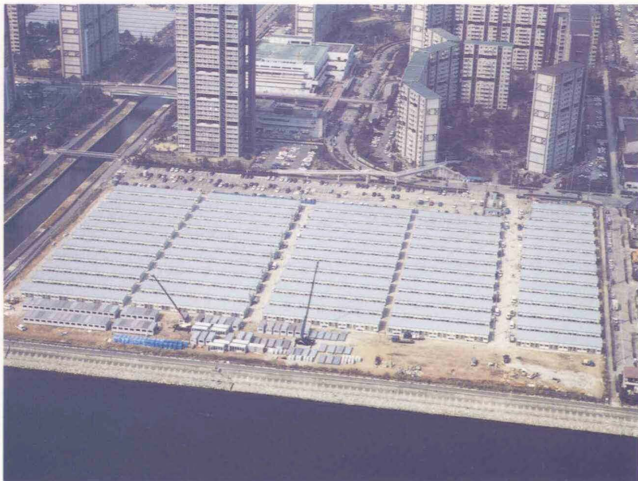
芦屋浜、高浜町南仮設住宅（航空写真）（H7. 3. 12撮影）
