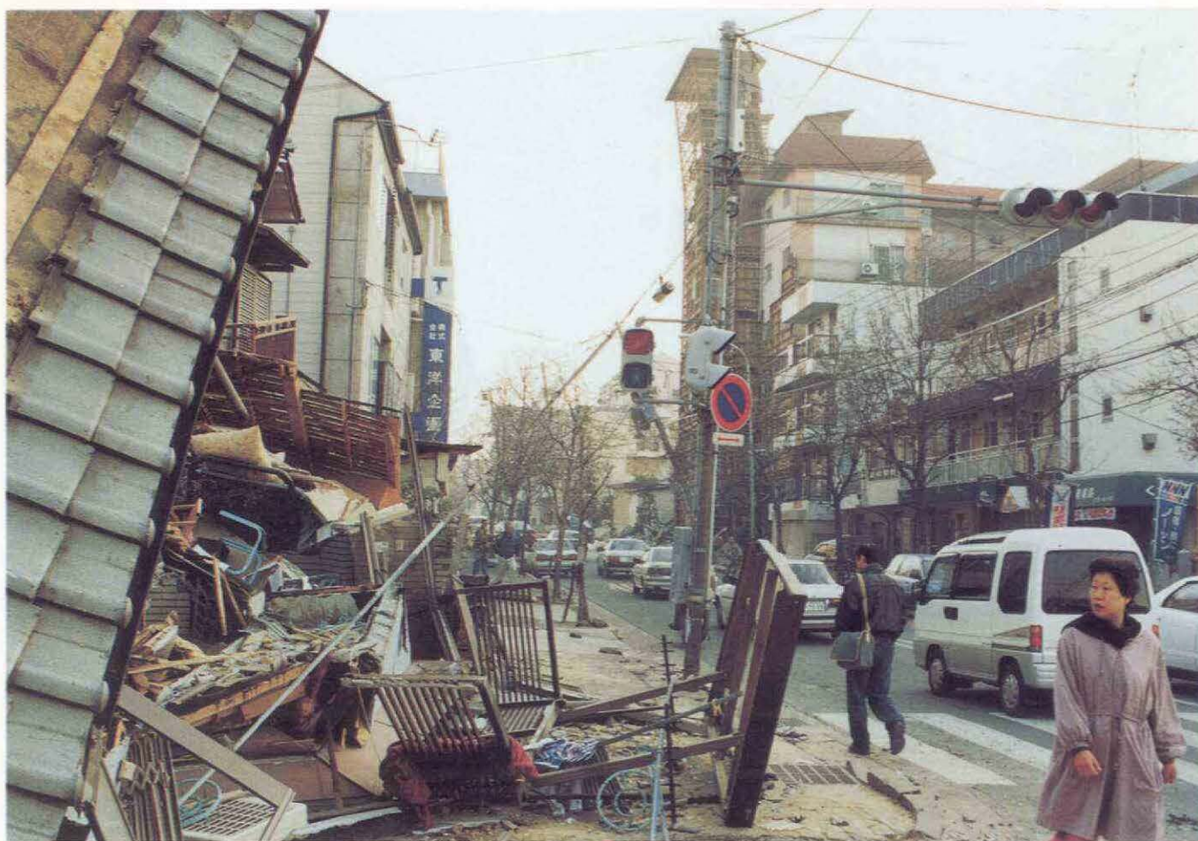
神戸市東灘区深江北町1丁目、鳴尾・御影線付近から芦屋方面(東方面)をのぞむ (H7. 1. 18撮影)
