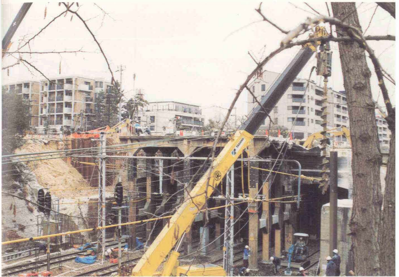
芦屋川左岸JR跨線橋
