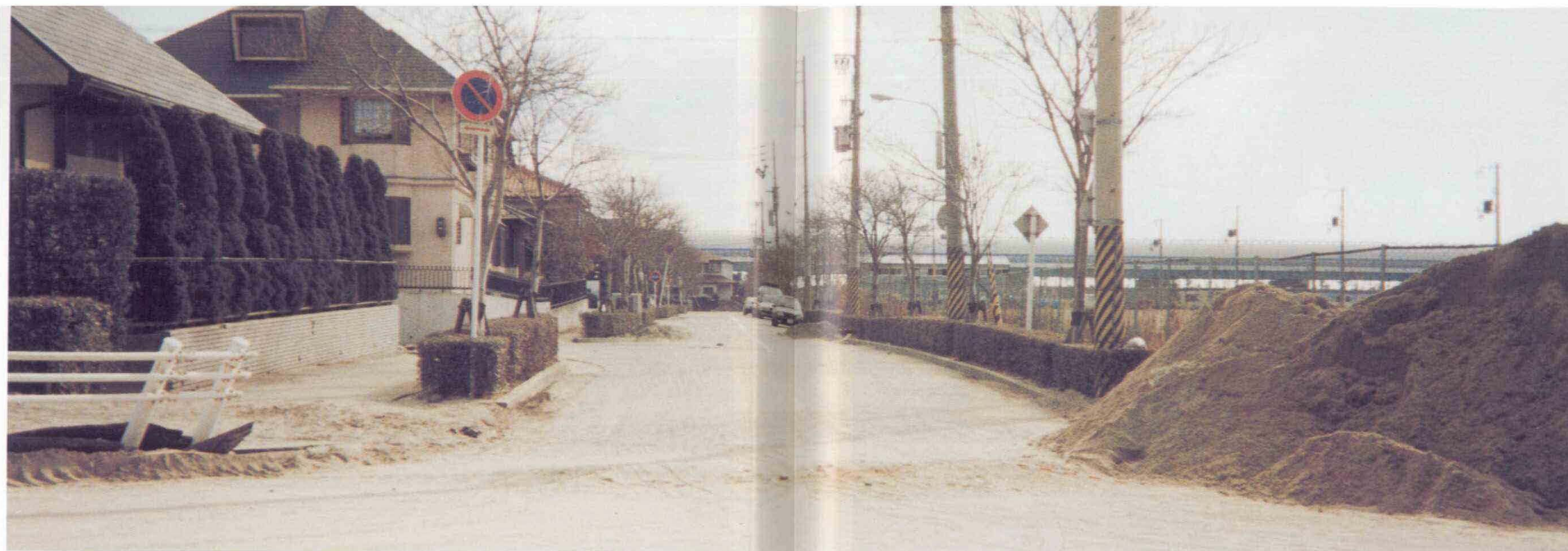
芦屋浜地区液状化
