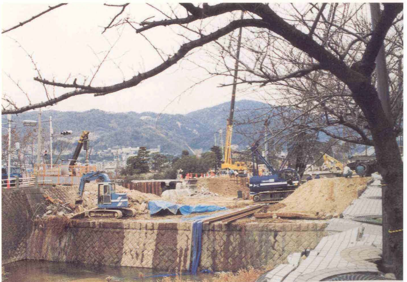
芦屋川左岸JR跨線橋
