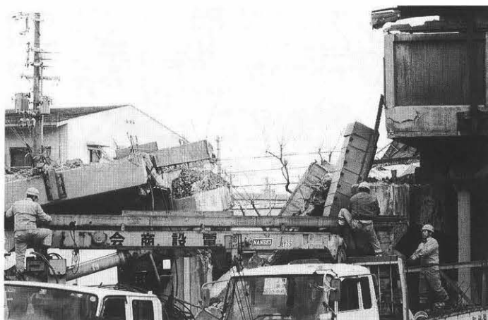
阪急電鉄甲東園駅と門戸厄神駅間に落下した新幹線の高架
