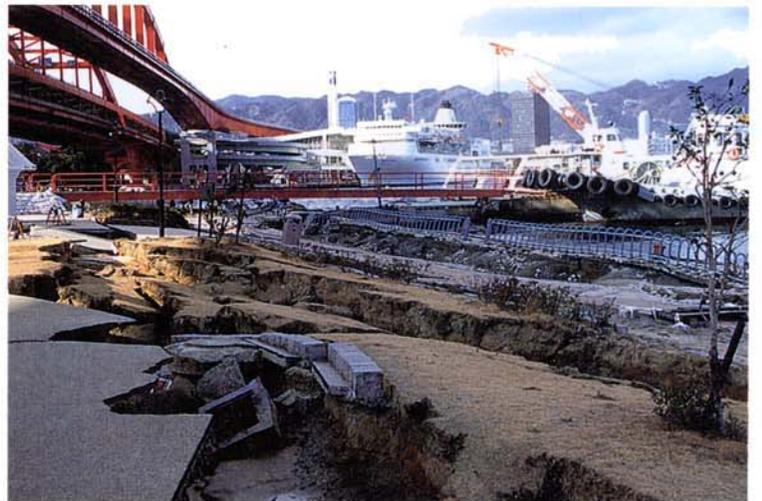
大きな地割れにより破壊されたポートアイランドの岸壁(1月17日 中央区)
