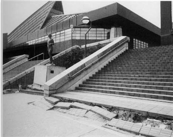
地盤沈下が起こり床や壁に亀裂が入ったポートアイランドスポーツセンター（中央区）
