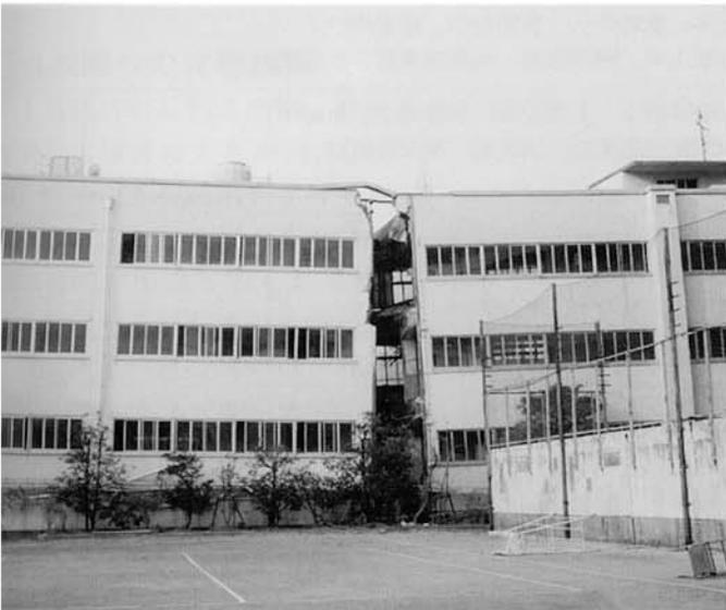
1階が圧壊し、エキスパンションジョイント部が開いた校舎（御影中・東灘区）
