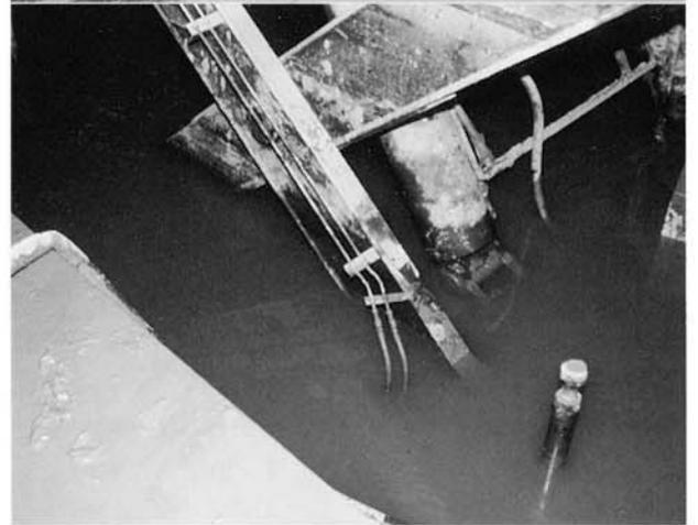
神戸ポートアイランドホールは液状化現象で地盤が沈下し、泥水が流出（中央区）
