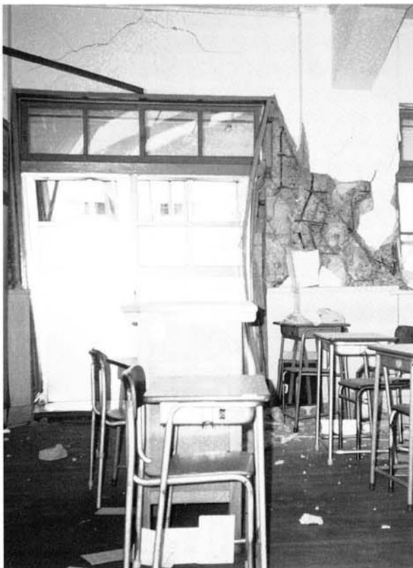
壁が落ち、出入口が破損した教室（飛松中・須磨区）
