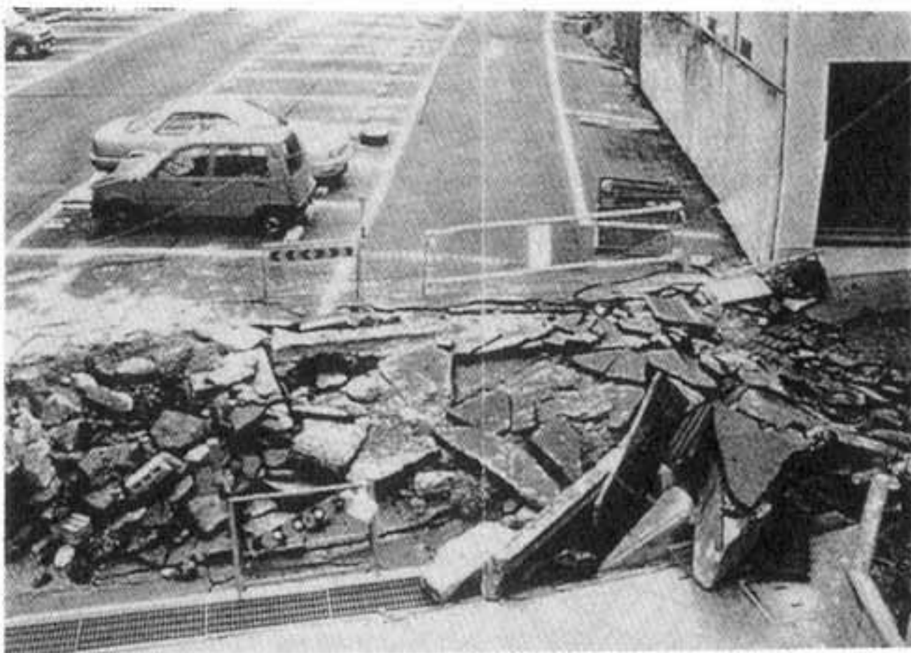
写真2 都市域の丘陵地（住宅密集地）の地すべり。（左）芦屋市三条町の地すべりの側方境界の破碎面（駐車場側が右から左へ移動した），（右）同地すべり末端部の噴砂現象（兵庫県砂防課）。
