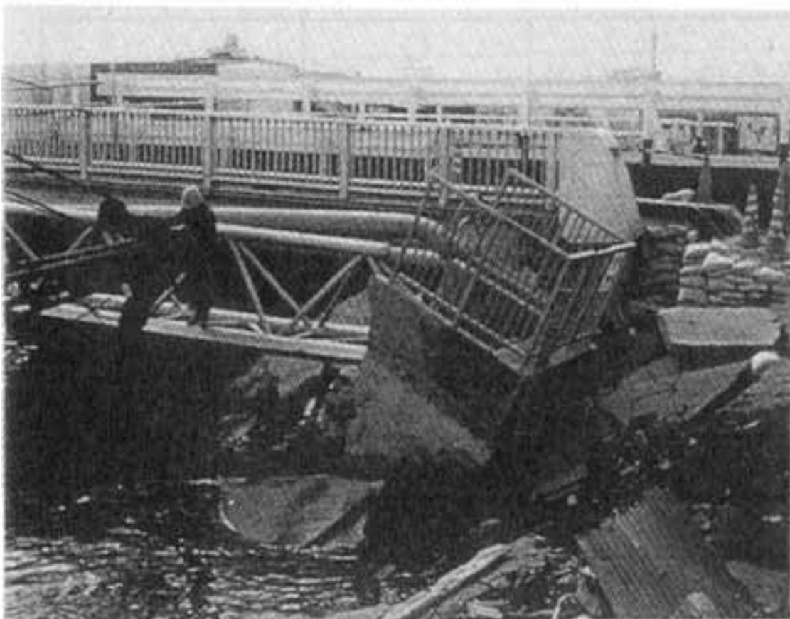
図8-6-4 地盤の大変状をうけたがガス導管が健全であった事例
