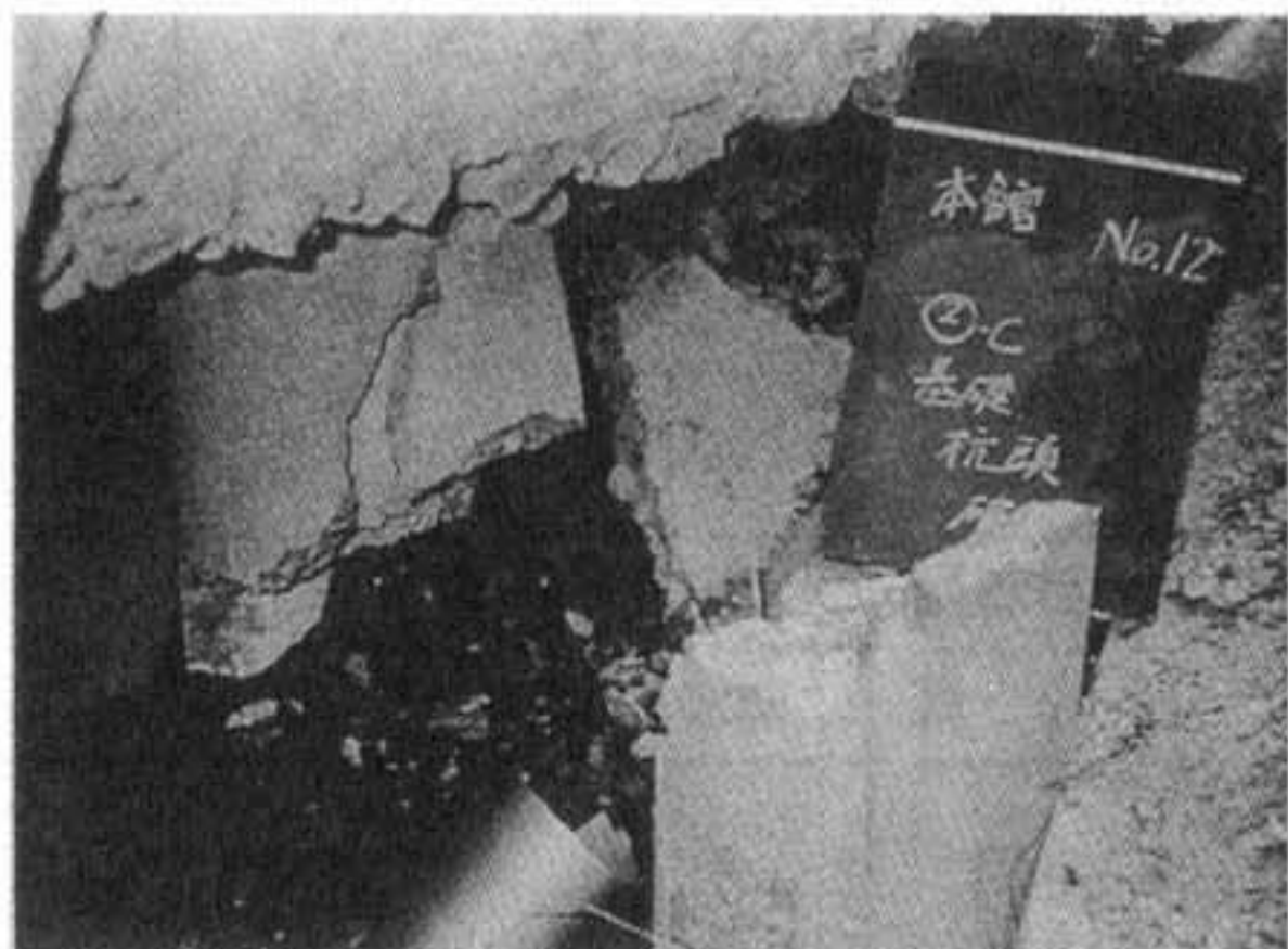
写真1 杭頭破断
