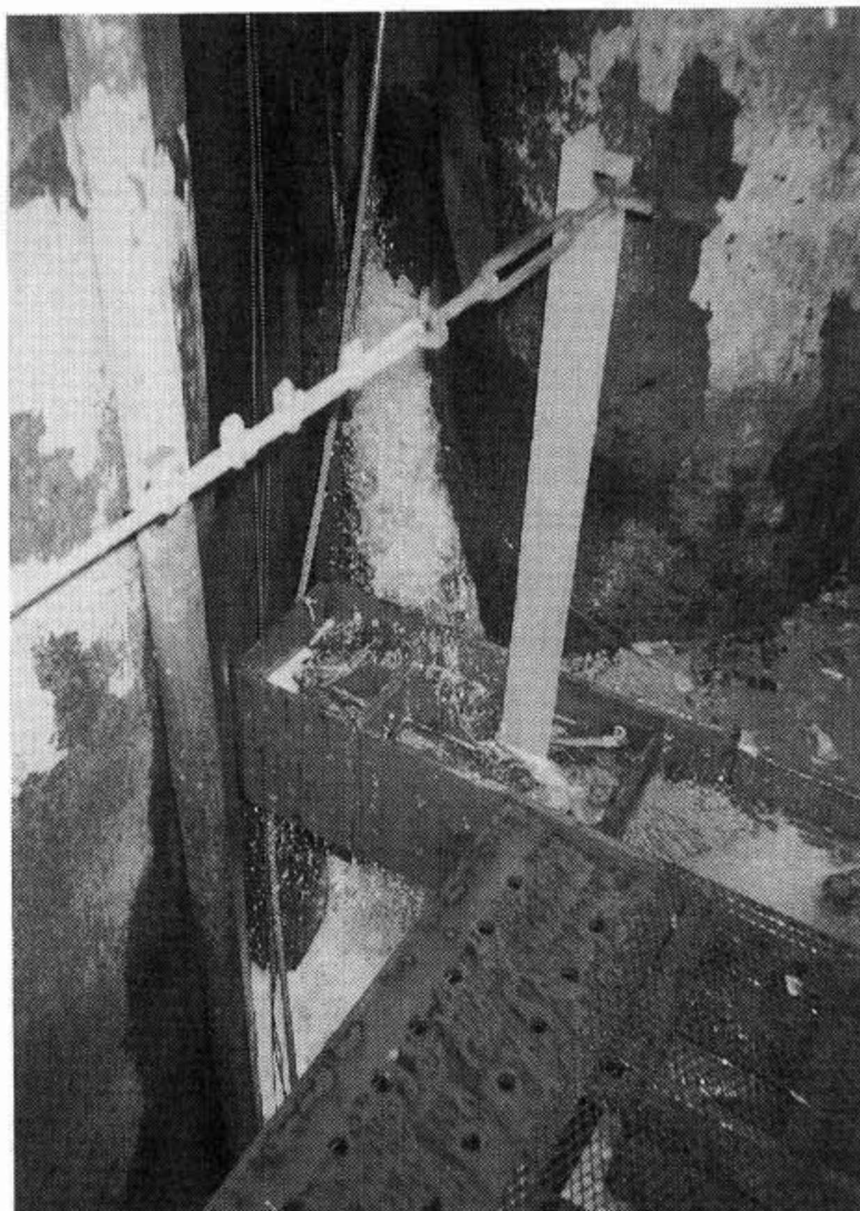
写真-3.5.2 コーナ一部における出水状況
