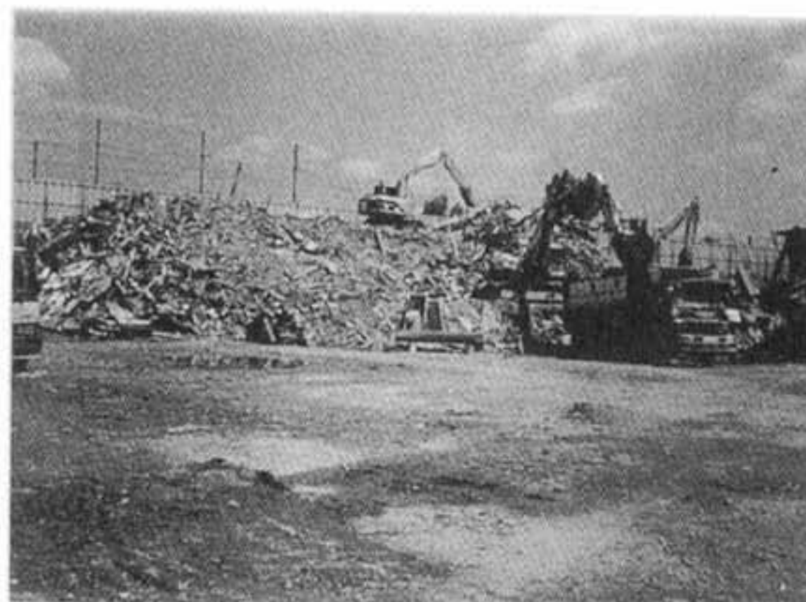
写真13.3.3.2 木材仮置き状況（伊丹市の仮置き場）
