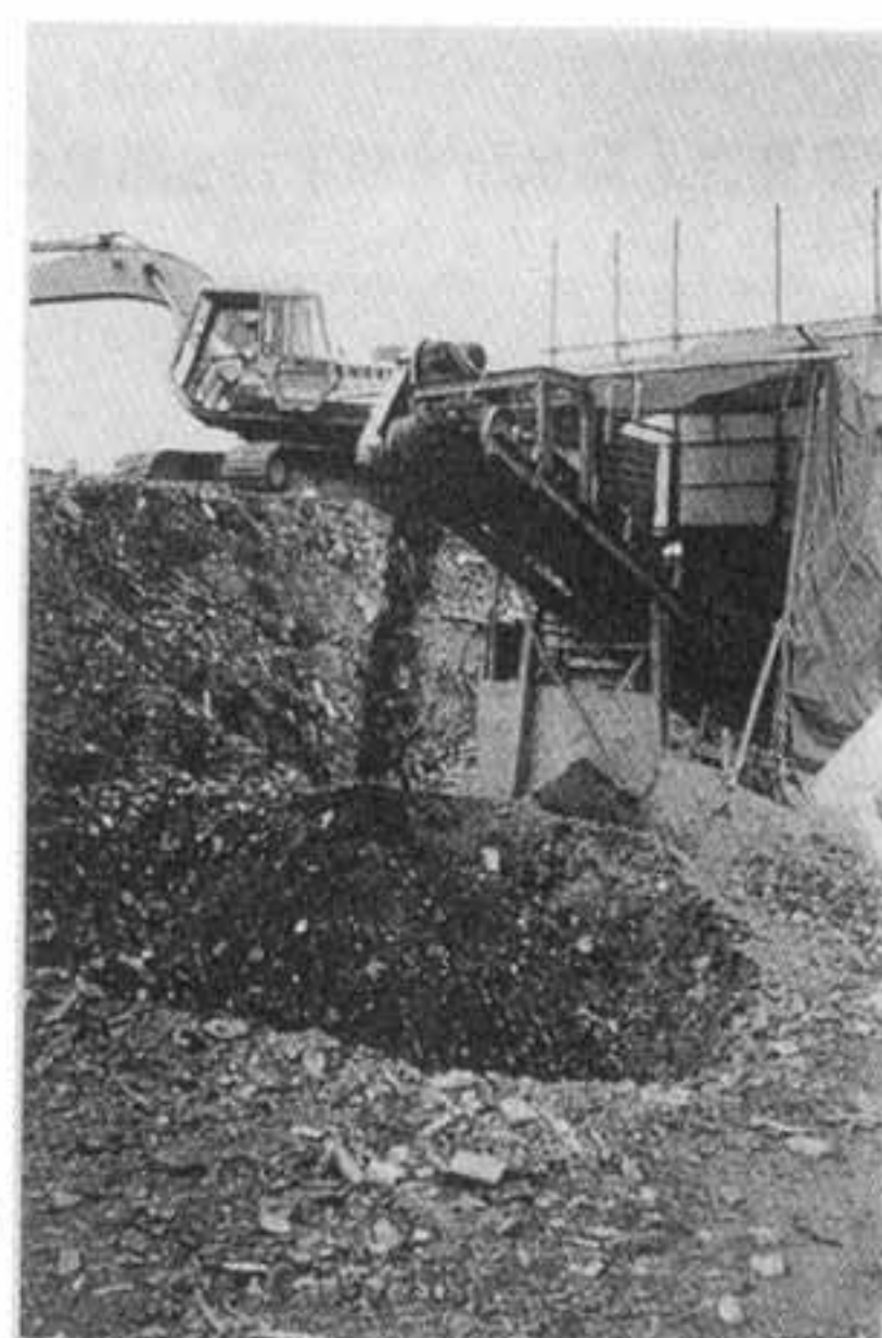
写真13.3.3.6 振動ふるいを通過したがれき （伊丹市の仮置き場）
