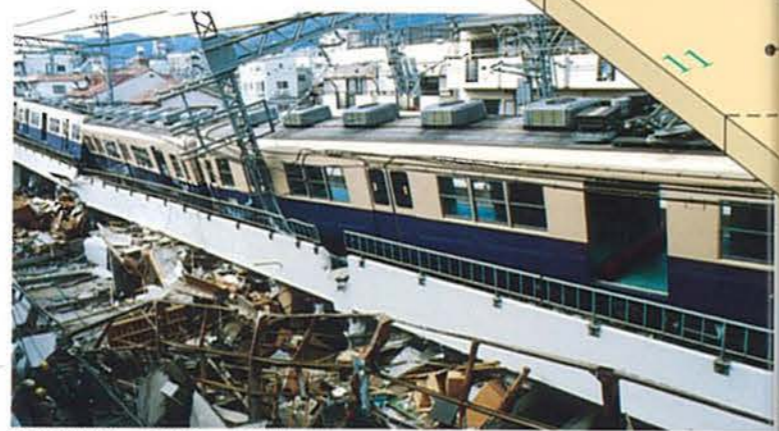
高架が崩れ、脱線した阪神電車
