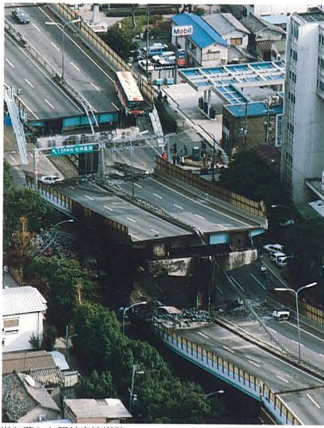
崩れ落ちた阪神高速道路
