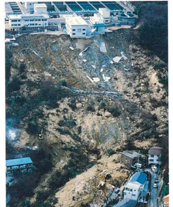
西宮市仁川では土砂崩れが発生、34人が生き埋めになった
