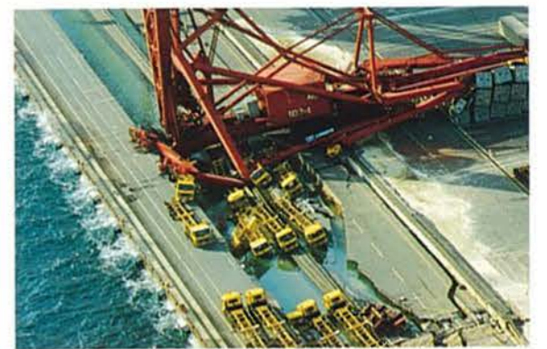
神戸港では岸壁が陥没、コンテナが海中に沈んだ
