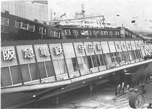
鉄道施設の被害は大きかった
