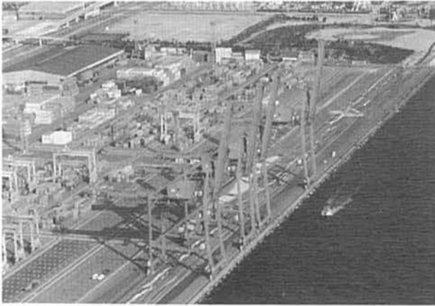
大型コンテナクレーンが脱線するなど被害は大きかった
