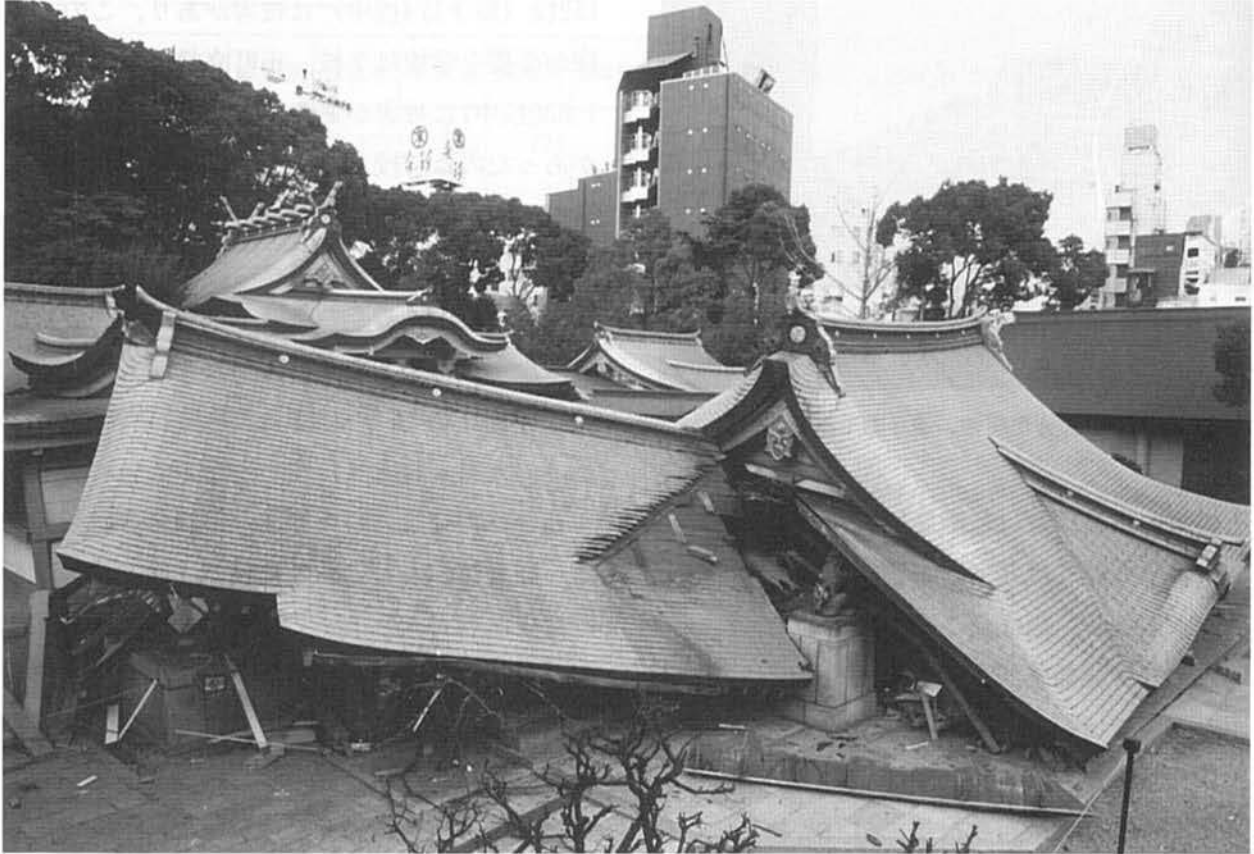
文化財も例外なく被害を受けた。拝殿が倒壊した生田神社
