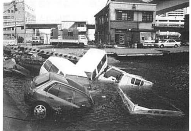
ミナト神戸の岸壁は壊滅的な被害を受けた
