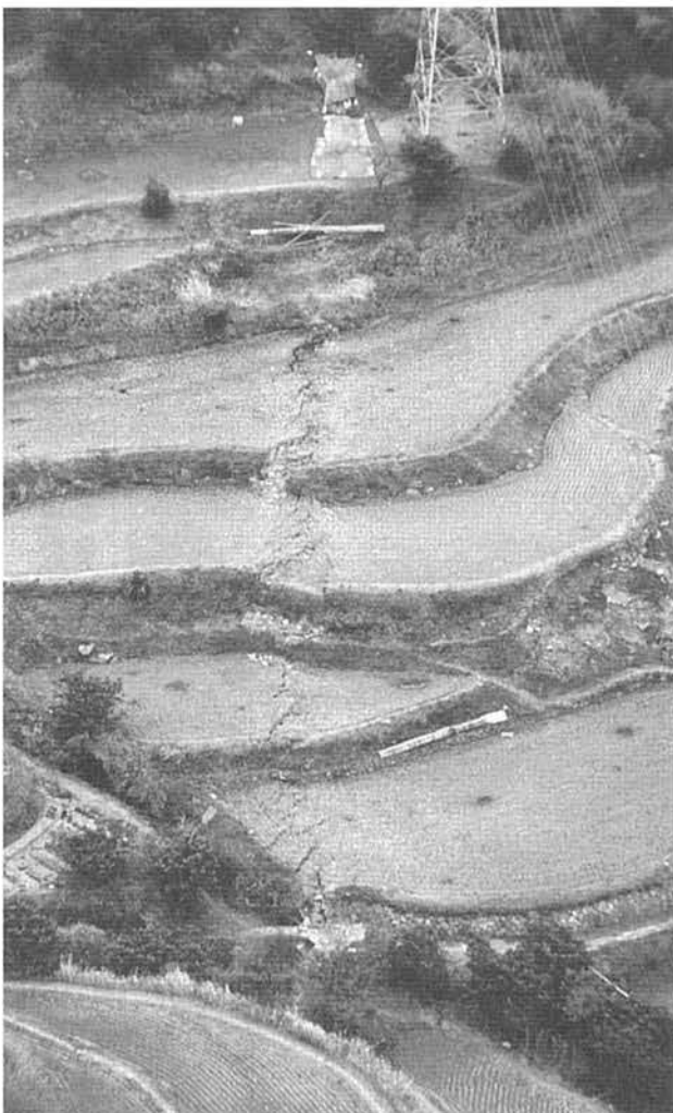
断層亀裂は9 kmにわたって露頭した
