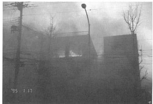
種々の要因で耐火性能が機能せず、延焼した例がみられた
