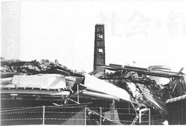
木造の酒造蔵の大半は全壊状態であった な被害を受けた。
