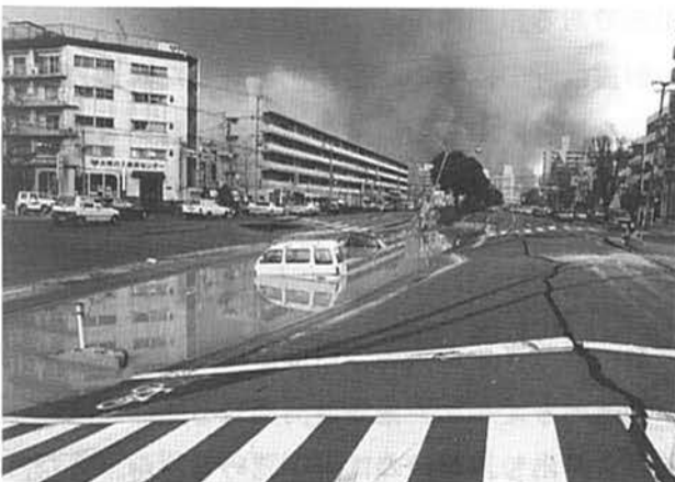
神戸高速鉄道大開駅付近の真上が陥没した
