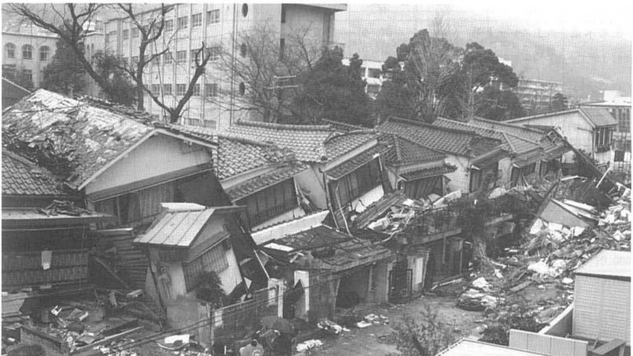
木造住宅倒壊率100%の街区もあった
