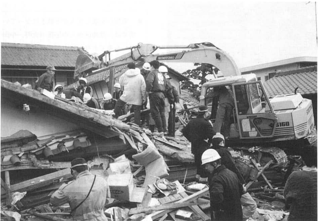
重機の威力は大きかった
