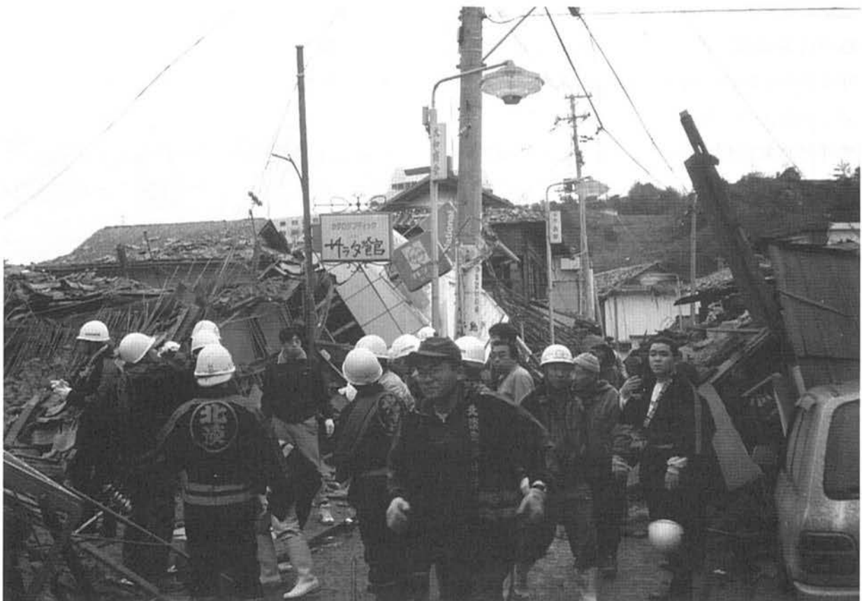
淡路島で最大の被害を受けた北淡町
