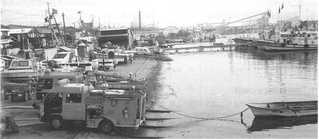
長田港に水利部署。長距離中継送水体制が整った
