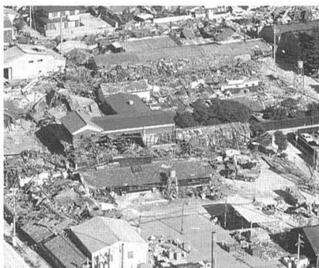
壊滅的な被害を受けた酒蔵工場も復旧に向けて動きはじめた
