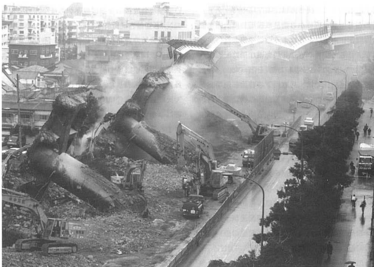
主要道路を重点に復旧が進められた
