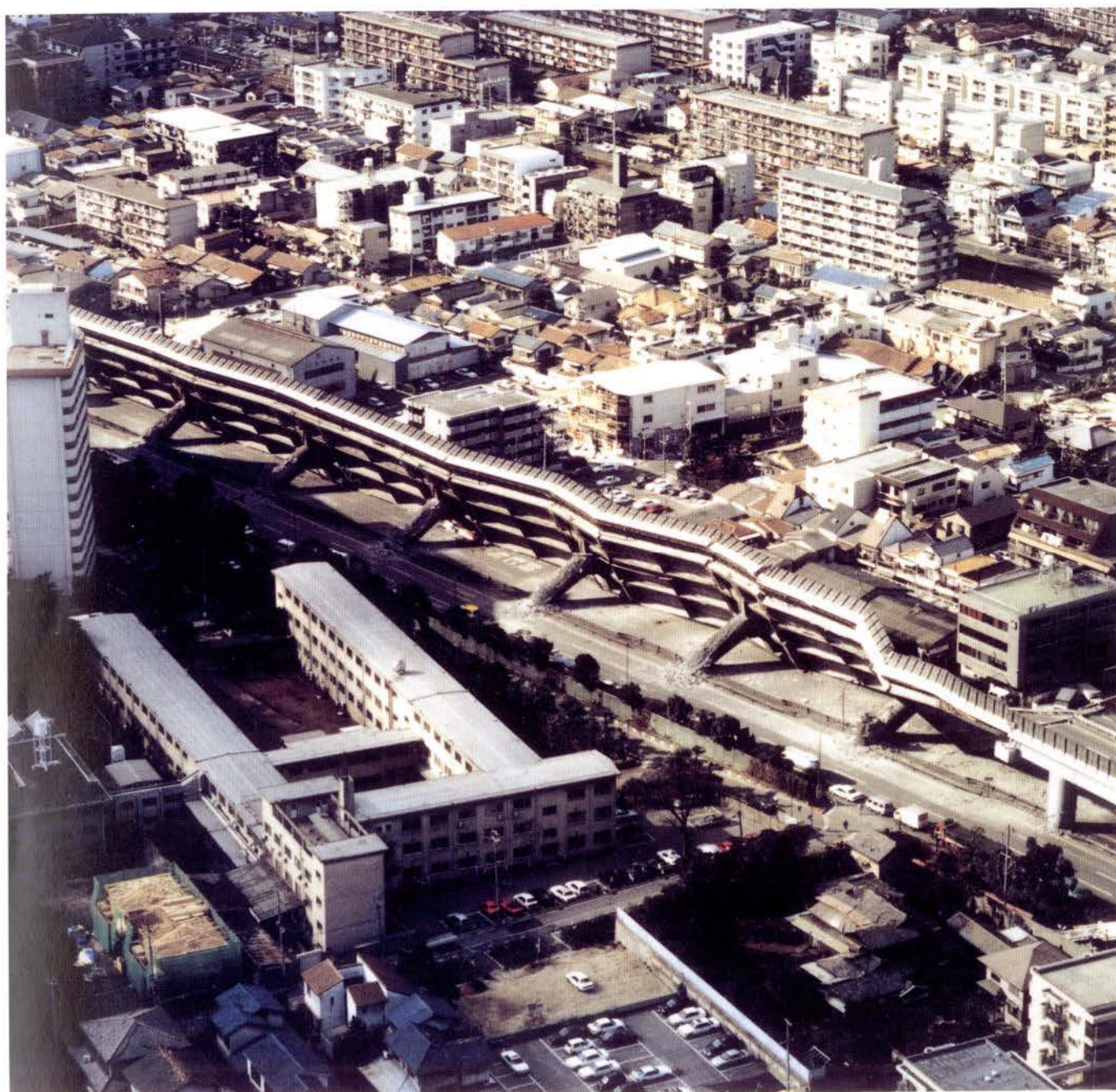
③ 神戸市東灘区 阪神高速 神戸線 RCピルツ型式の高架橋は全長630mにわたって山側に倒壊した。
