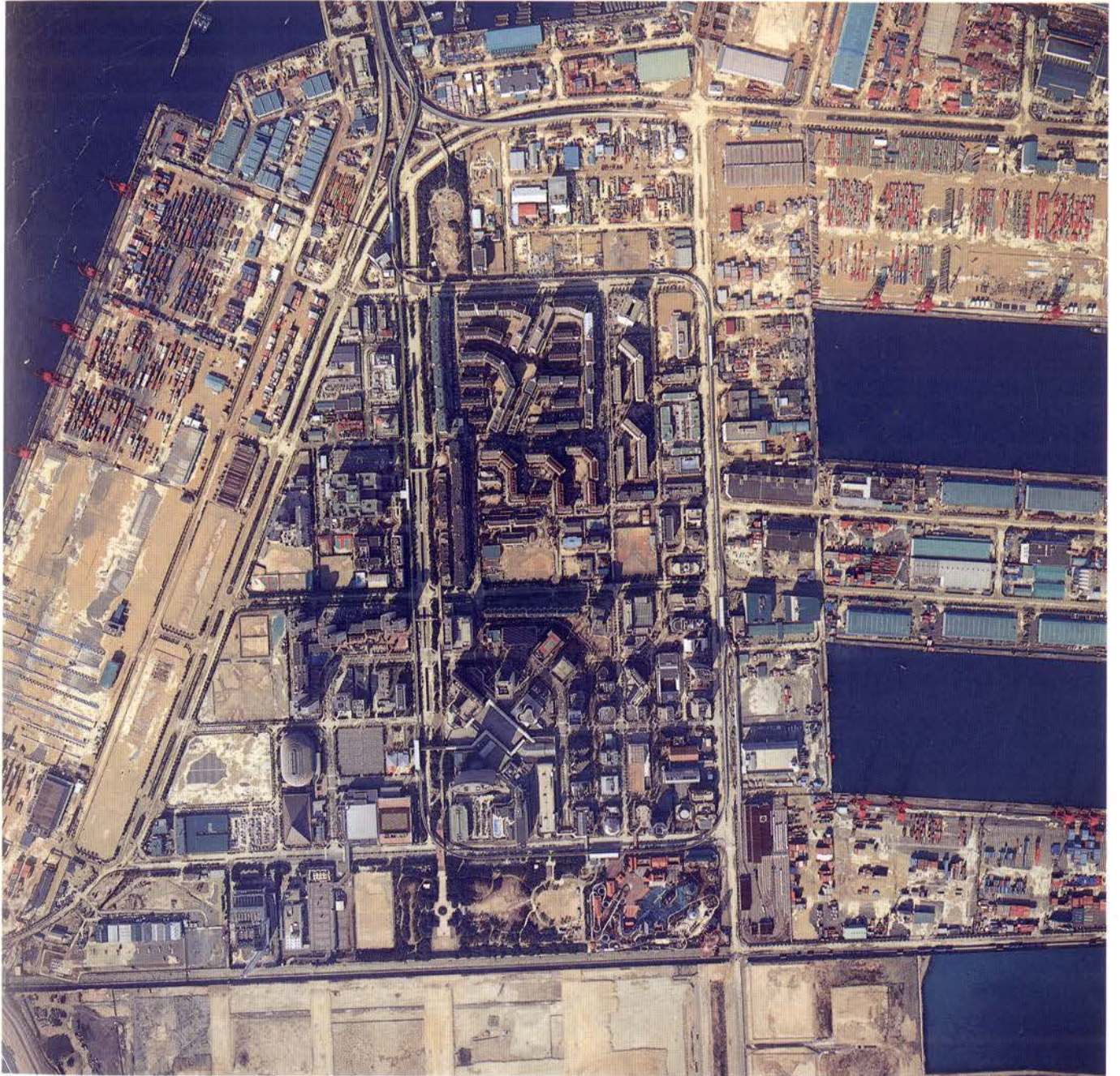
⑤ 神戸市ポートアイランドの液状化 (1月21日 12時15分撮影) ポートアイランドはほぼ全域で液状化現象による噴砂の跡が黄色く残った。
