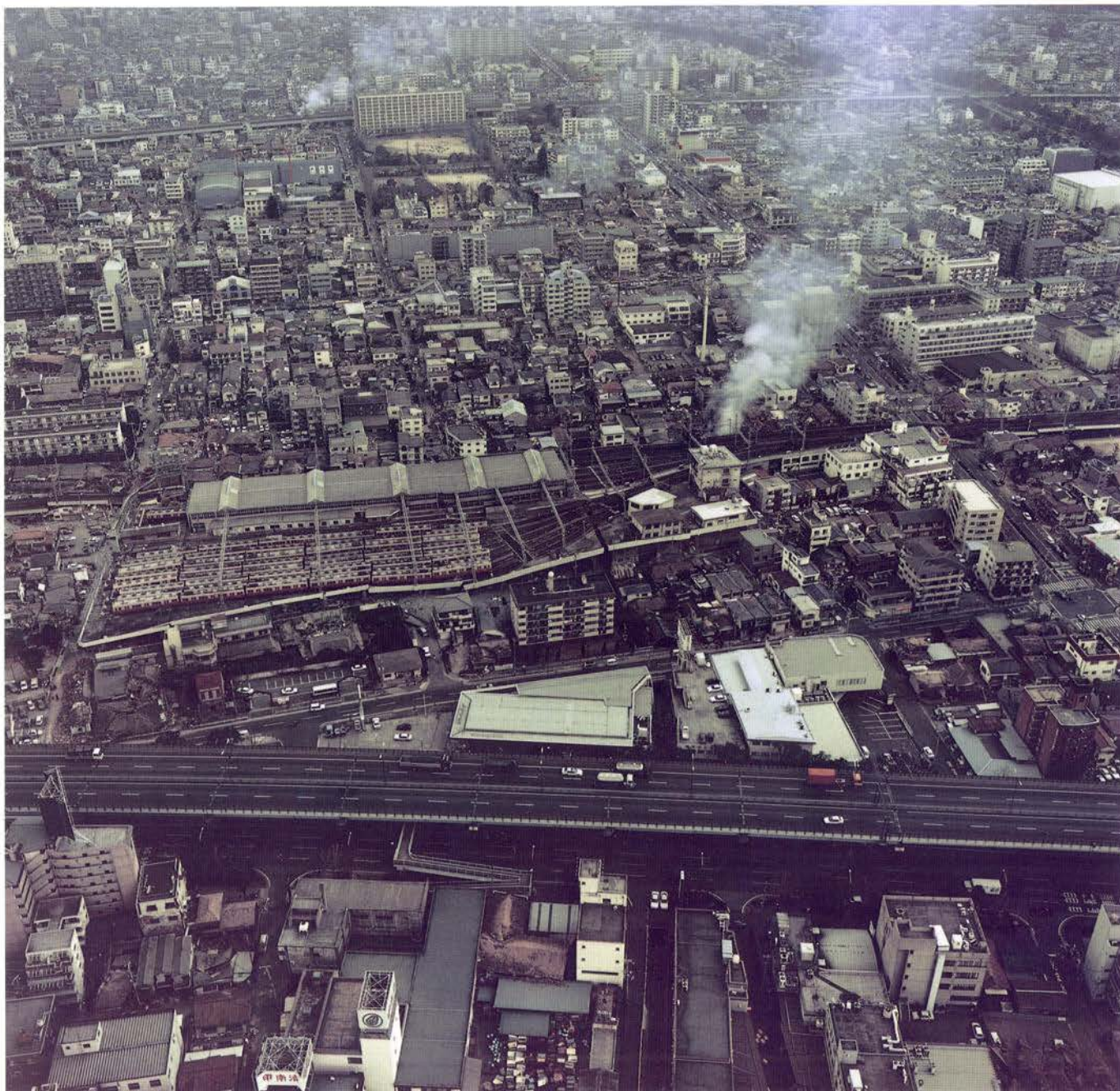
④ 神戸市東灘区 阪神電鉄石屋川車庫付近 高架構造の車庫は柱が狂壊し全壊にいたった。
