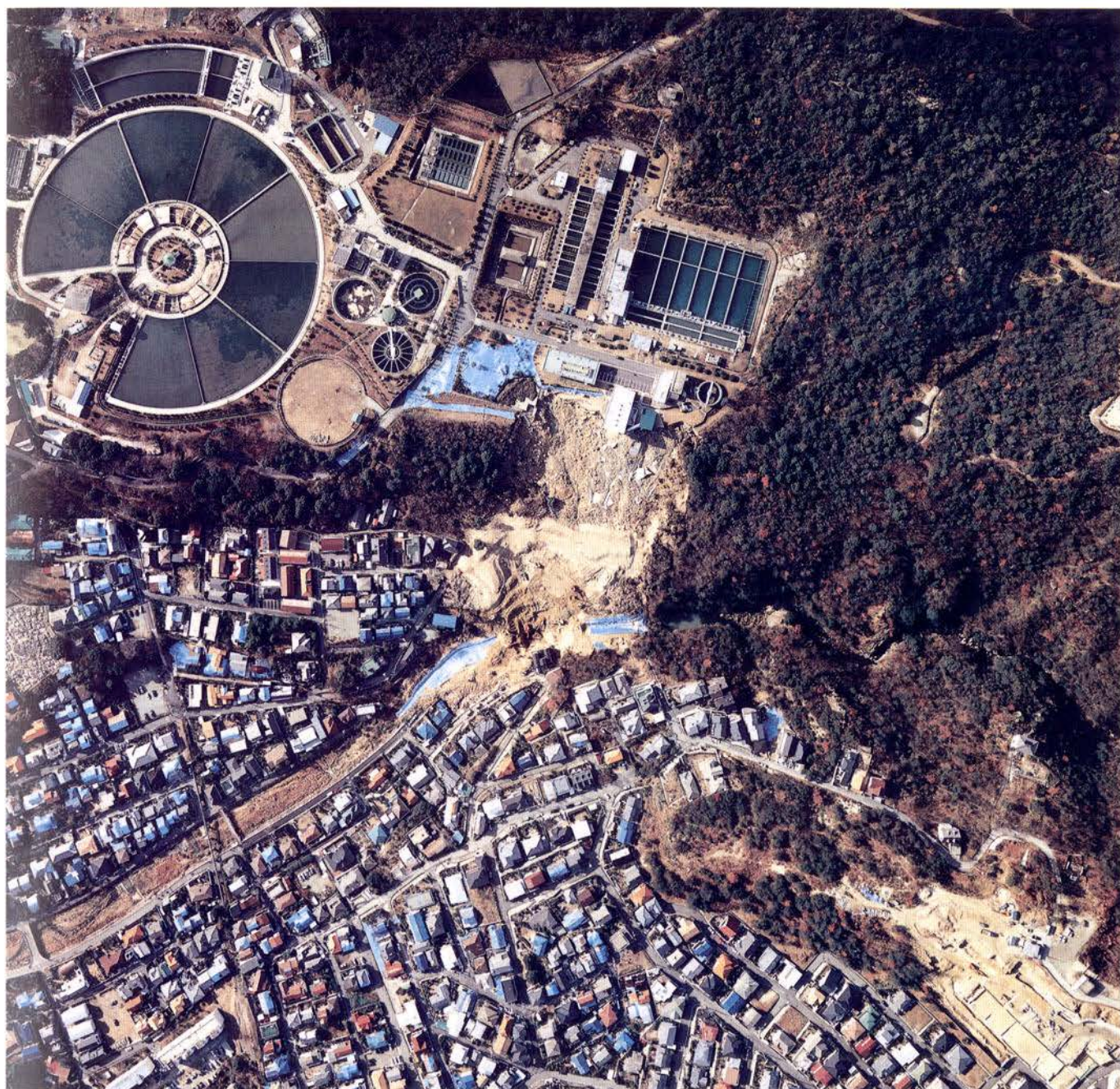
⑦ 西宮市仁川の地すべり現場 (1月21日 10時38分撮影) 崩壊土砂はII世帯を呑みこみ、河道の中に見られる青いシートの先端まで達した。
