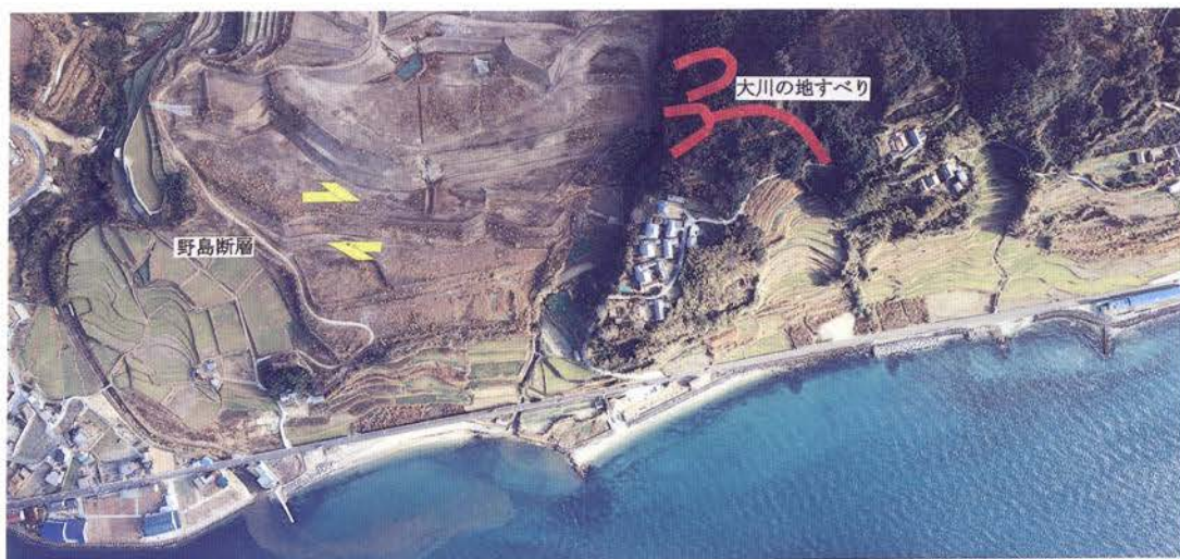
写真-9.23 野島断層東側の凸状斜面に地すべりによる亀裂が生じている
