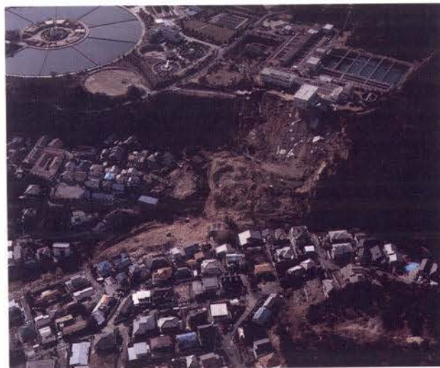
写真-9.13 地すべり地の全景
