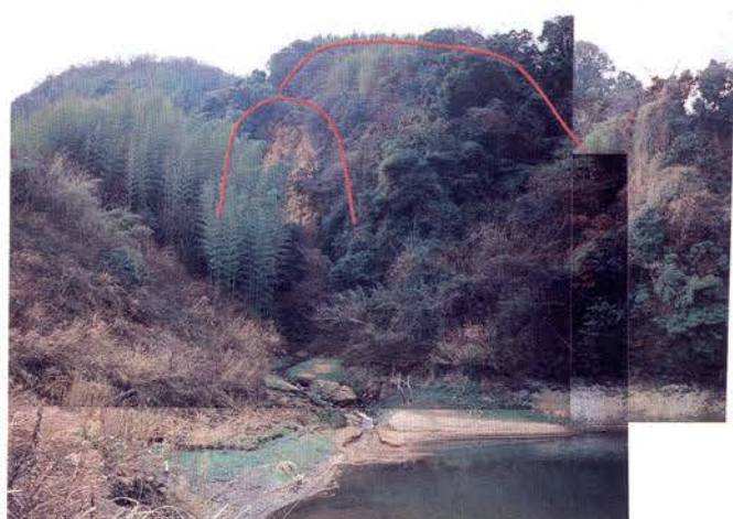
写真-9.24 地すべり地の全景
