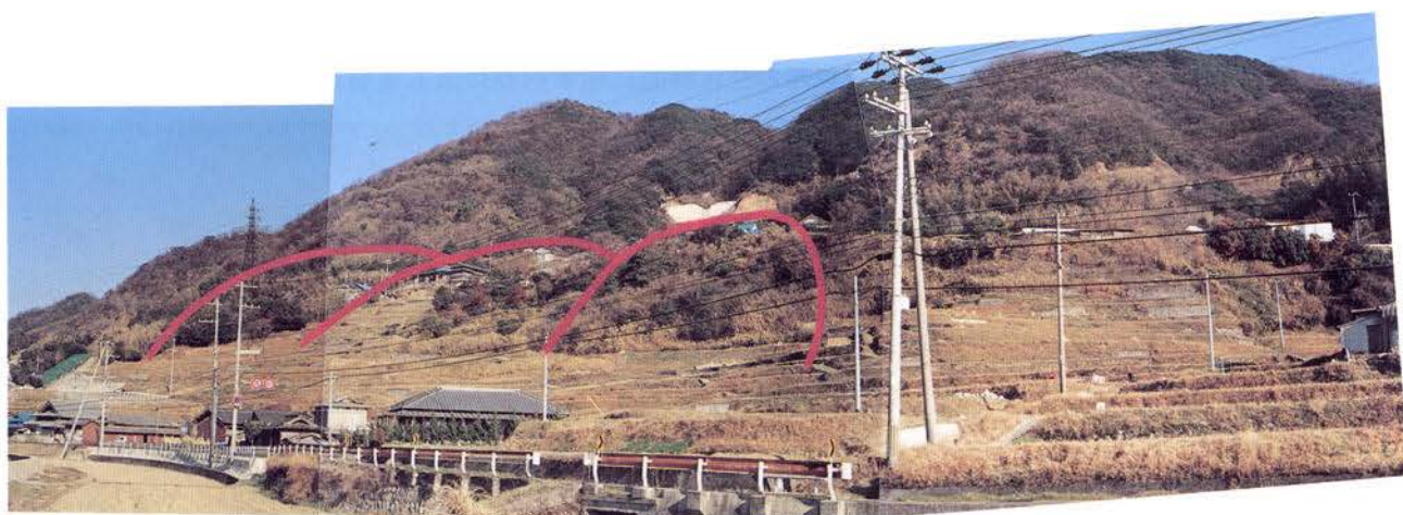
写真-9.29 地すべり地の全景
