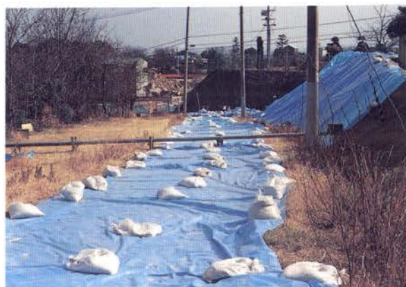
写真-9.17 地すべり地に隣接する斜面に生じている亀裂（下方には人家が密集）
