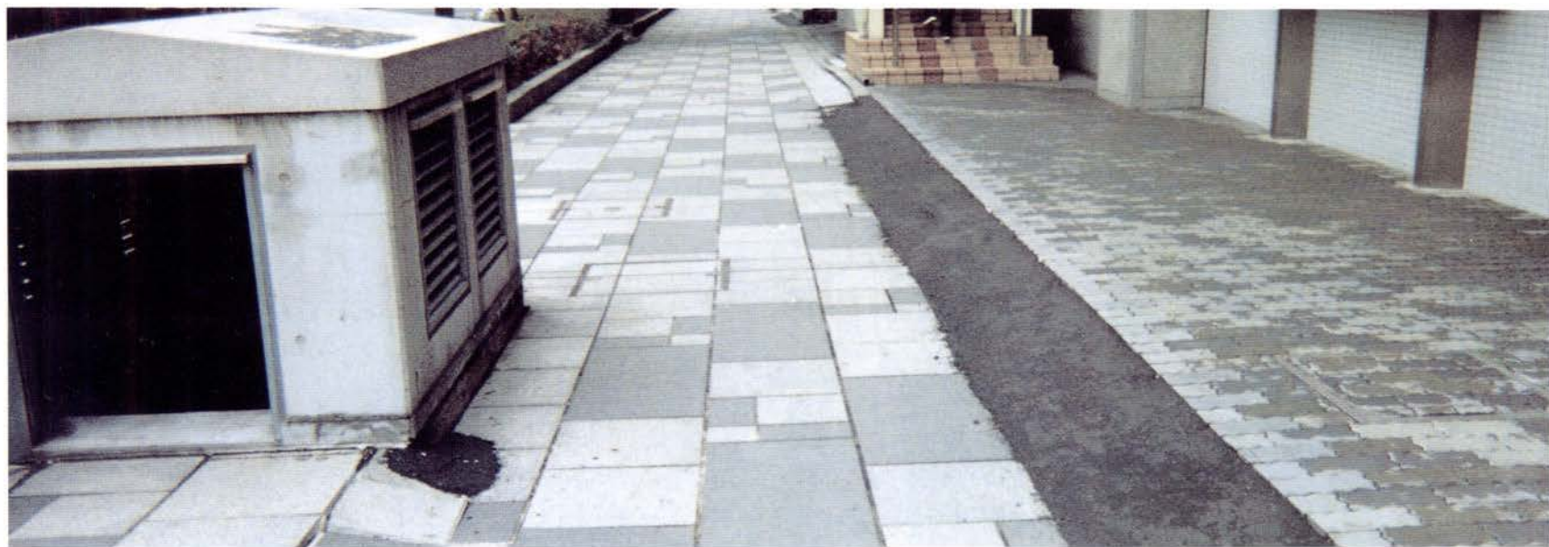
写真-6.10 神戸市海岸通り七丁目付近 共同溝出入口部構造物の損傷なし
