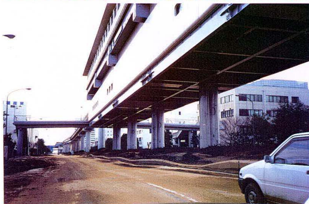
写真3 ポートアイランドにお ける液状化による噴砂 と道路の凸凹
