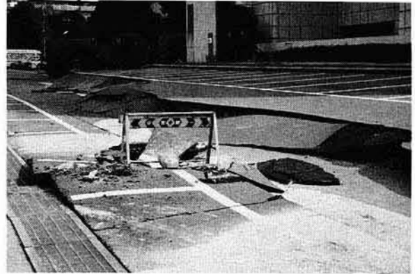
写真① 道路のあちこちに見られる亀裂
