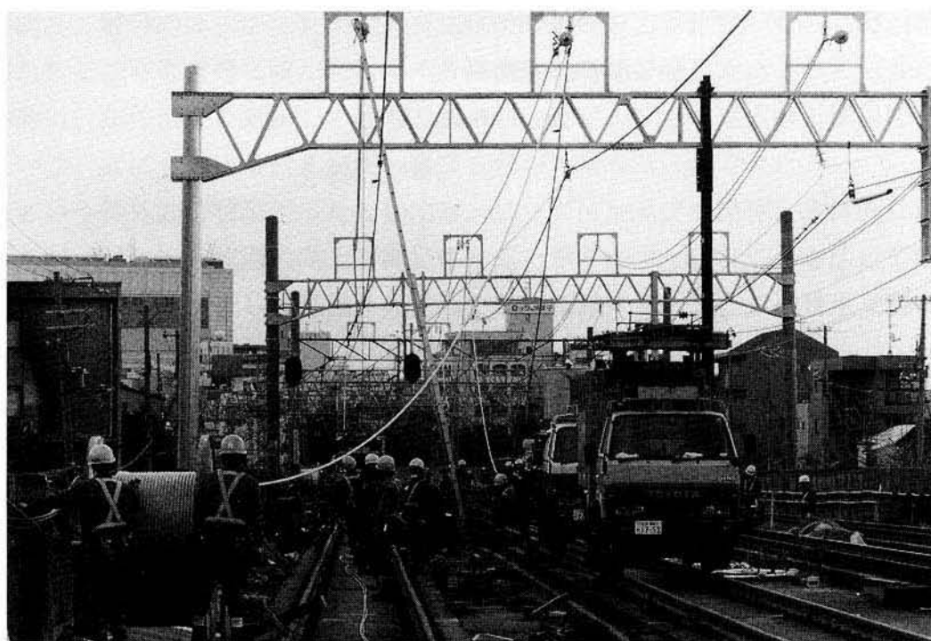
軌道復旧工事の仕上げ、架線の敷設が進む
