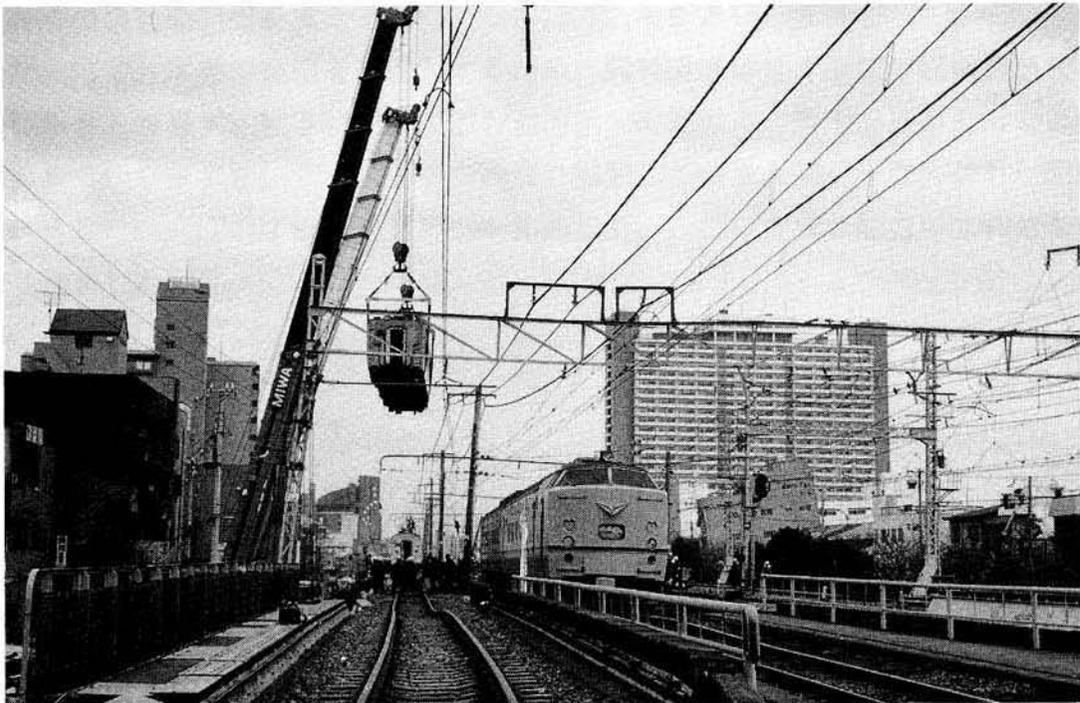
大型クレーンを投入しての脱線列車の復線作業
