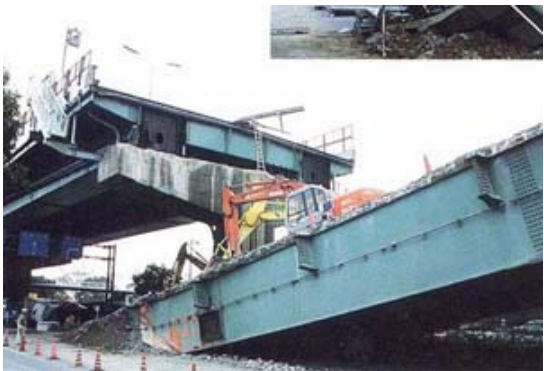
崩壊した阪神高速道路
