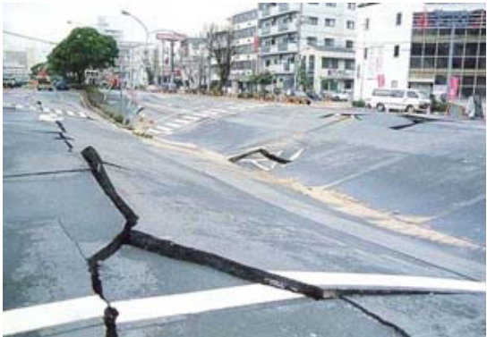
陥没した大開通。地下には神戸高速大開駅がある
