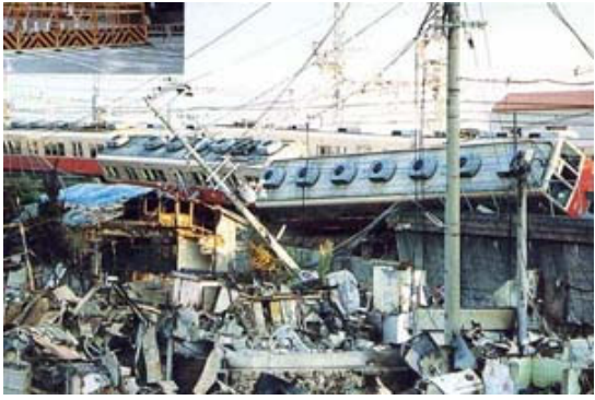
高架が崩れ阪神電車は脱線。周囲の建物も押しつぶされた
