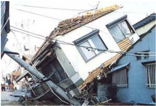
押しつぶされた民家
