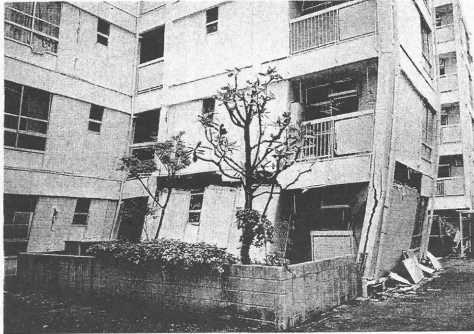
写真9 鉄骨の変形のため建物全体が弓形に曲がっている
