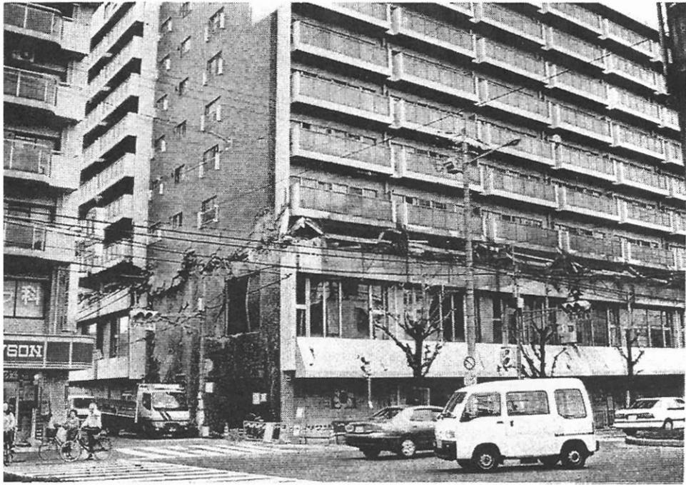
写真7 4階の店舗が崩壊している
