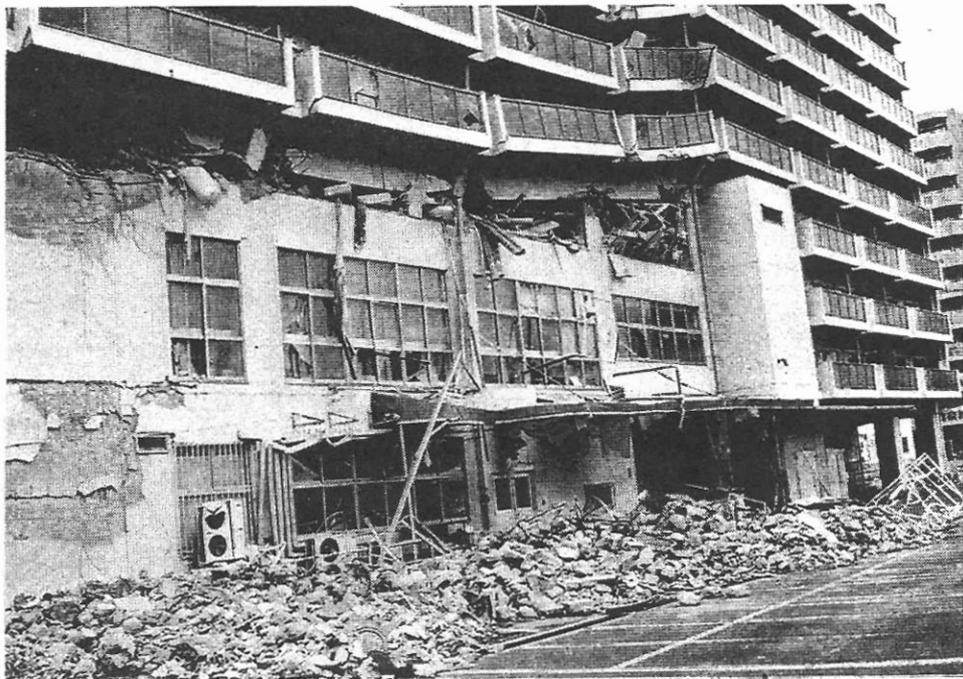
写真8 同じ4階でも住戸部分は崩壊していない
