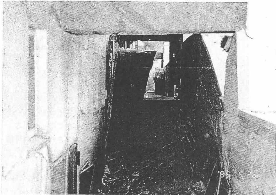
写真2 沈下している部分の廊下の状況
