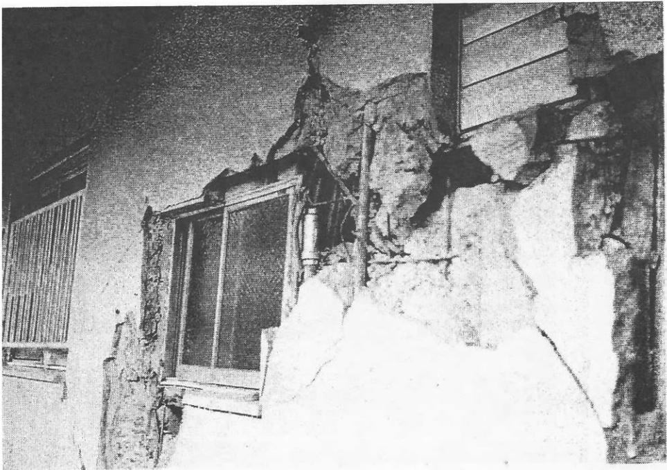
写真16 壁面がはがれ中が見えている
