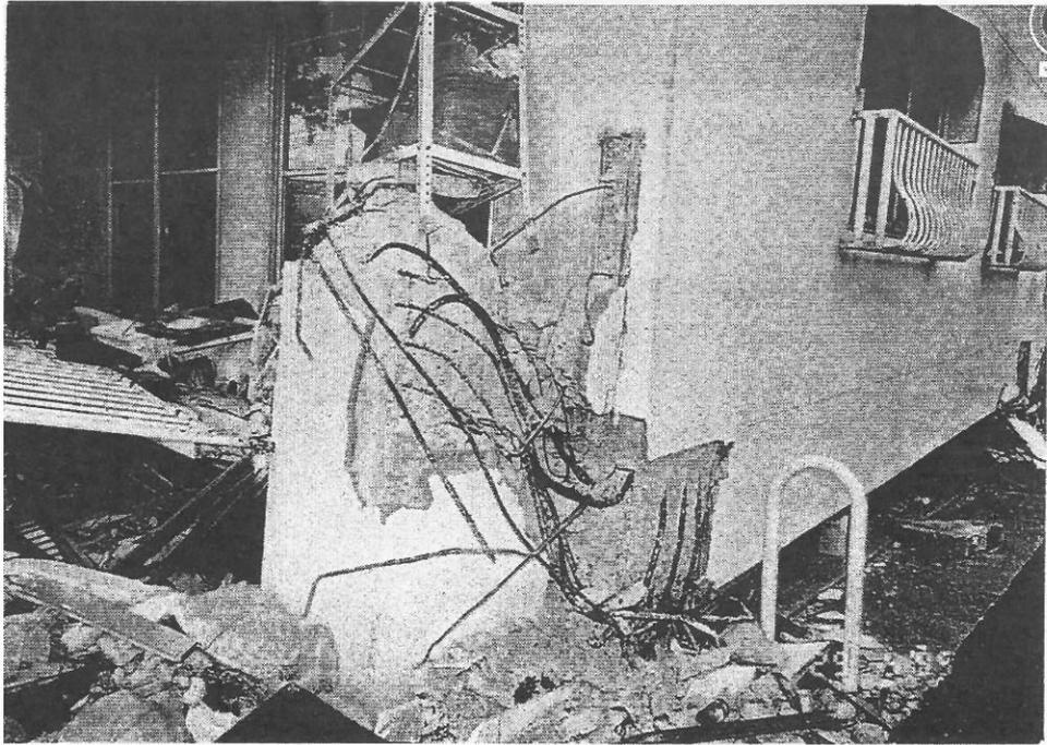
写真13 1階の柱が完全に破壊している
