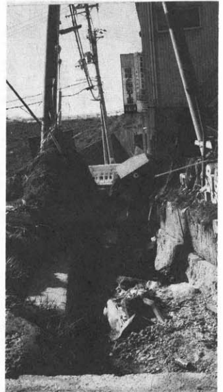
朝霧川逆流。逆流したあとの状況
