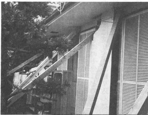
朝霧北町、加古さん宅 角材による支え①と ジャッキで持ち上げ修理
