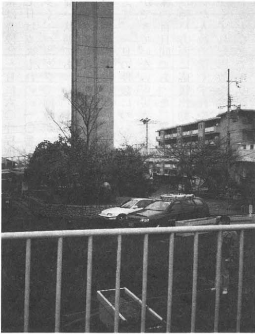
倒壊の恐れがあった松が丘給水塔
