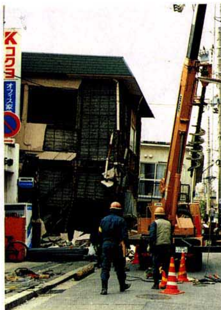
写真3.2.2.12 J建物 骨組の鋼材に著しい錆が見られる
