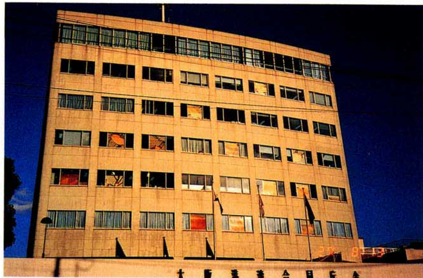
写真 3.2.4.4 全層で窓ガラスの破損，建物の被害は認められない
