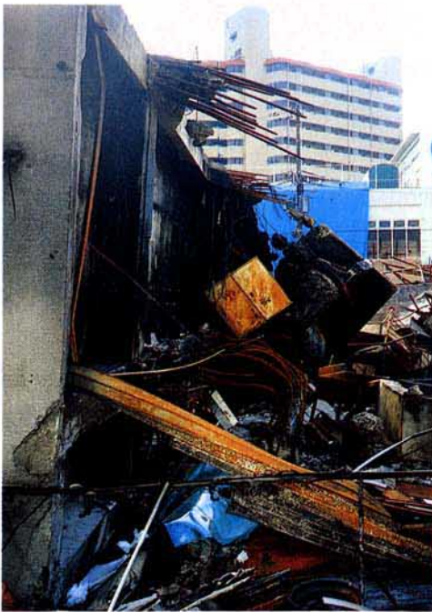
写真 3.2.1.18 建築物全体の転倒
