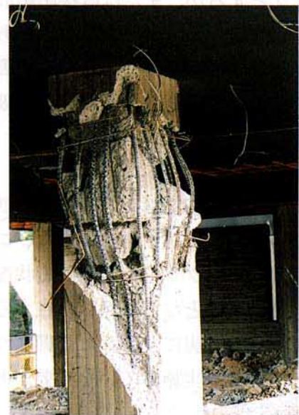
写真3.2.1.72 鉄筋末端部における 90° フックの例 (開いている場合)
