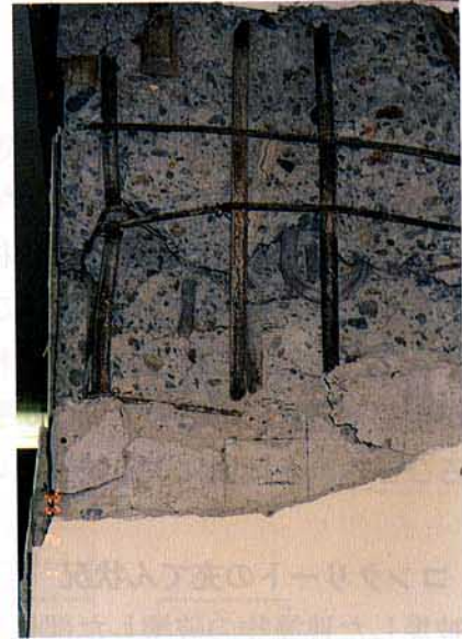
写真3.2.1.70 鉄筋末端部における 135° フックの例
