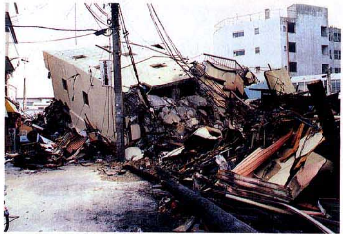
写真 3.2.1.17 建築物全体の転倒
