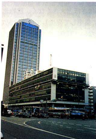
写真 3.2.1.3 8F事務所 ・6階が層崩壊した（奥は無被害のビル）
