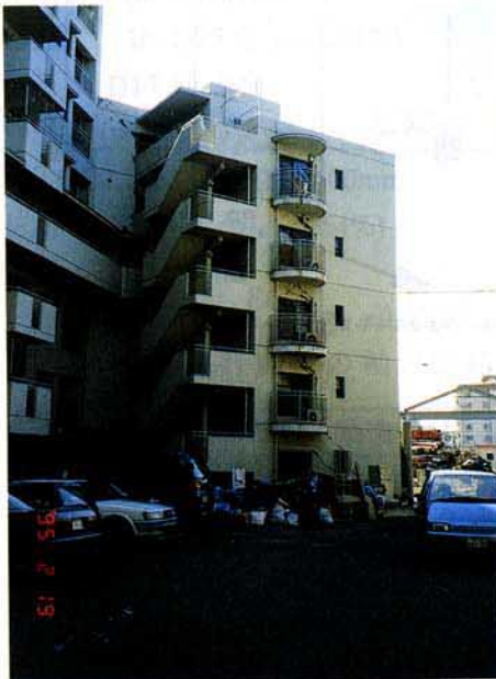
写真 3.2.1.57 5階建てビル南側
