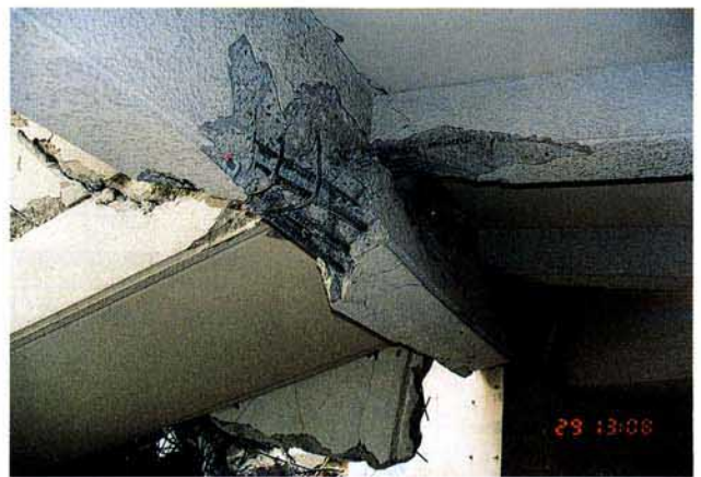
写真 3.2.1.32 はりのねじれ破壊
