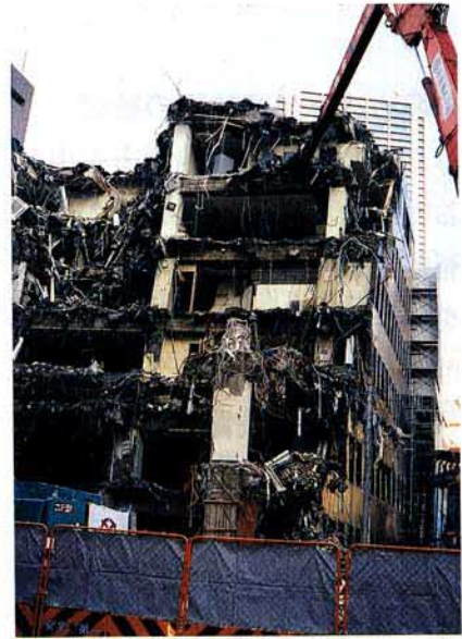
写真 3.2.1.59 建物解体現場
