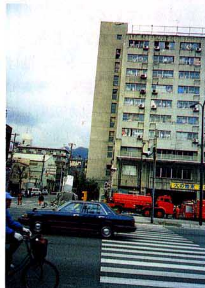
写真 3.2.1.21 ペントハウスの落下
