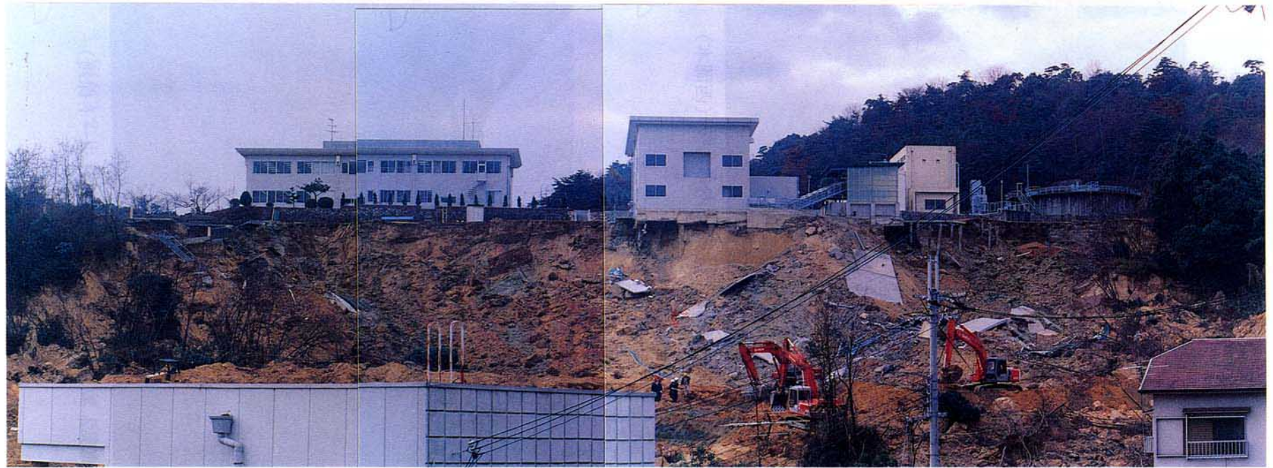
写真3.2.3.9 造成斜面の崩壊（西宮市仁川百合野町）
