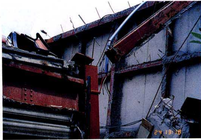
写真3.2.2.10 H建物 柱梁仕口部の柱-ダイアフラム溶接部、梁仕口溶接部の破断によって2階より上が転倒
