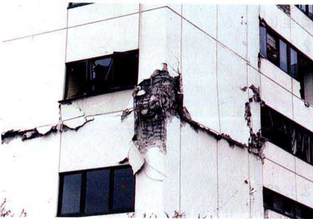
写真 3.2.1.20 異種構造 (SRCとRC) の間での破壊
