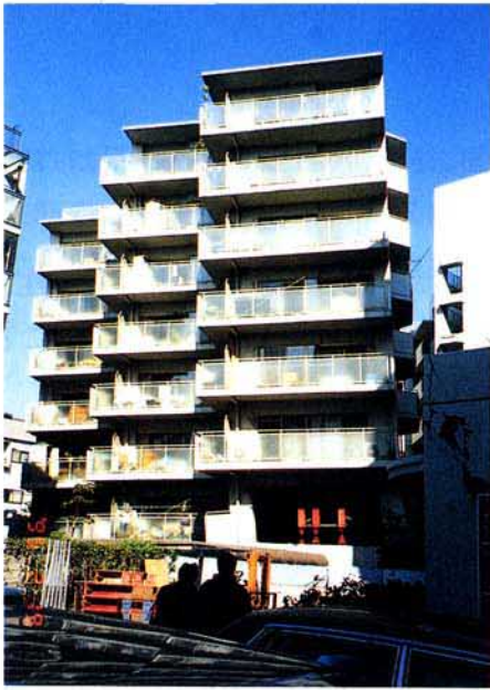
写真 3.2.1.49 8階建てアパート全景（南面）
