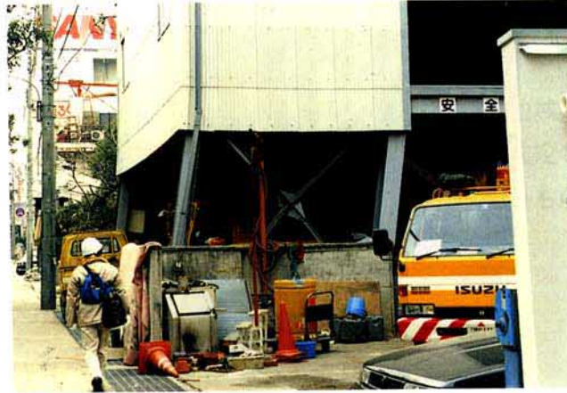
写真3.2.2.13 K建物 1階部分に水平変形が集中し、北側（写真右方向）に1/8程度の傾斜
