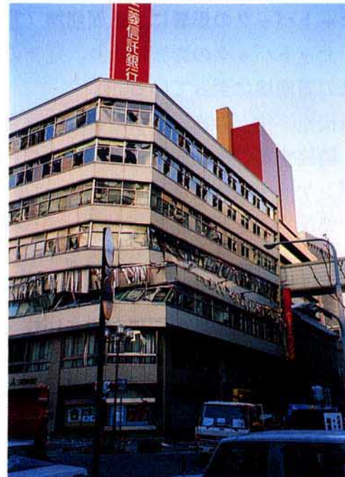
写真 3.2.1.19 ねじれ応答による層崩壊
