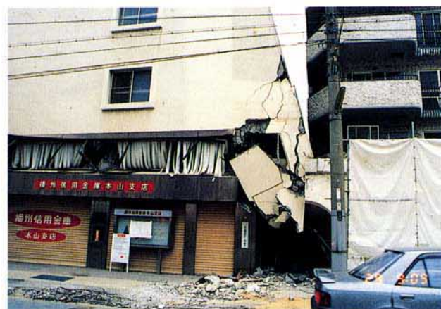
写真 3.2.1.26 隣接建築物との衝突による崩壊
