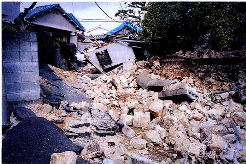
写真3. 2. 3. 16 個々の宅地被害（石積み擁壁）
