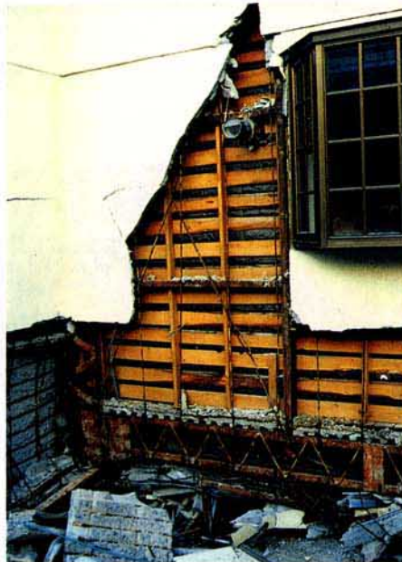
写真3.2.2.10 H建物 柱梁仕口部の柱-ダイアフラム溶接部、梁仕口溶接部の破断によって2階より上が転倒
