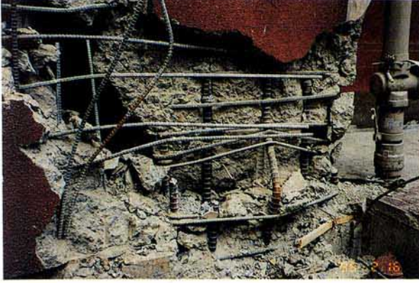
写真 3.2.1.63 柱脚の被害
