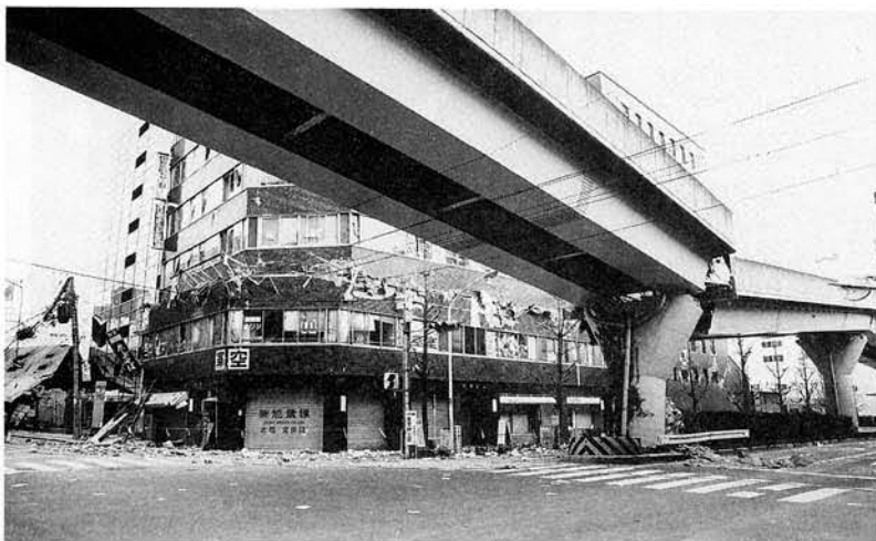
ポータルライナー支柱 (米田フォト提供)
