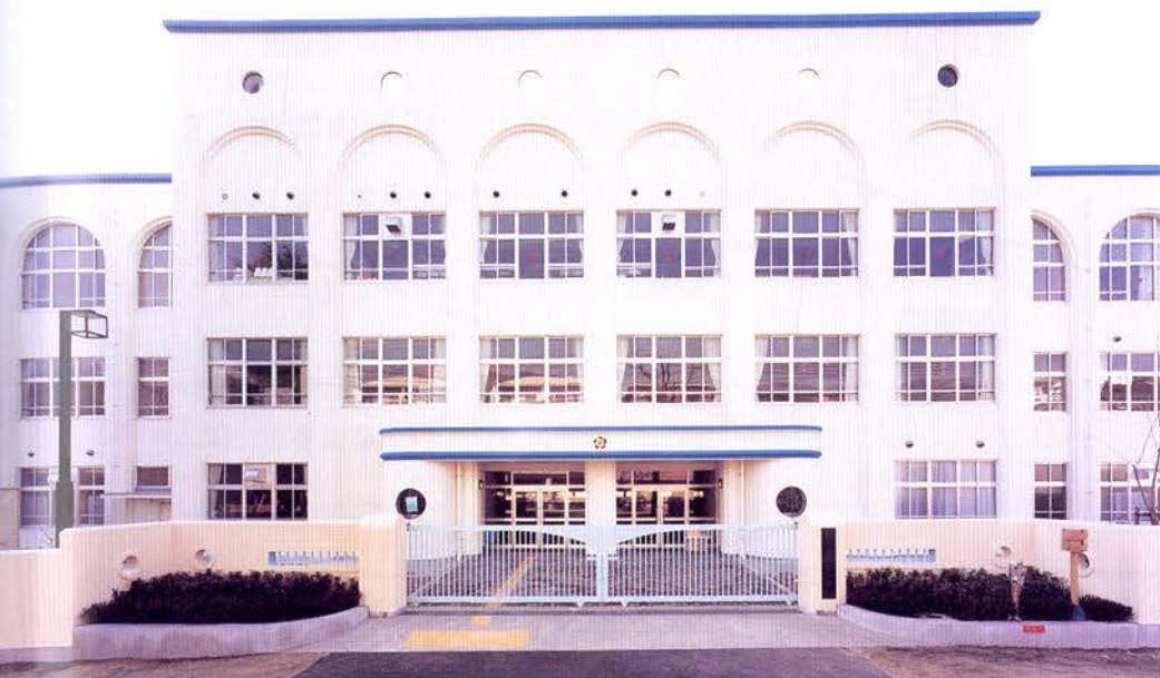
校舎前面 正門正面から撮影
