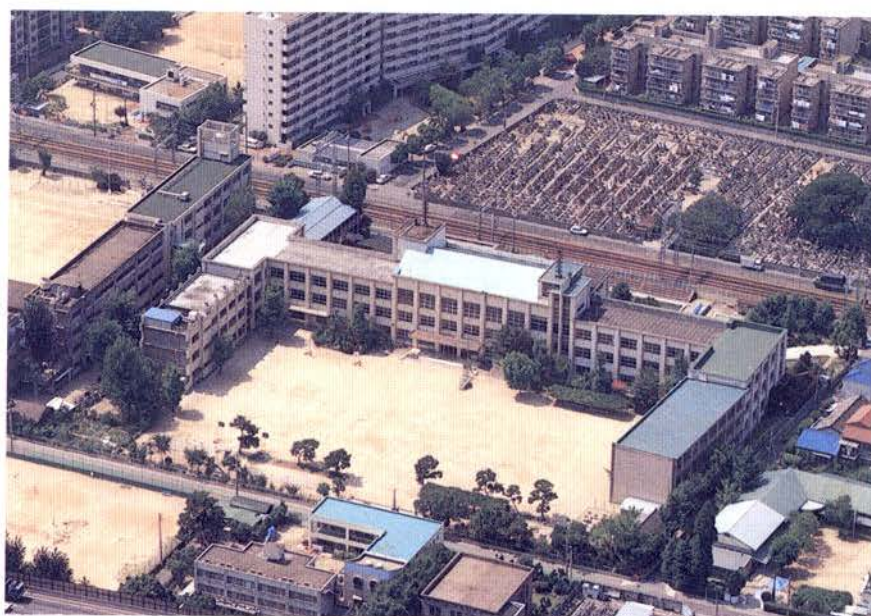
校舎全景 南東上空から撮影
