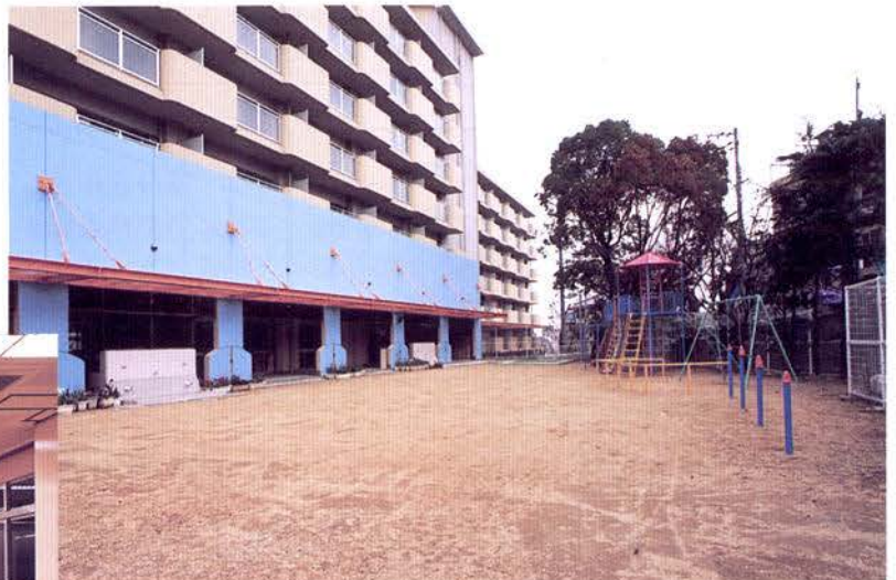
園庭より復旧された園舎をのぞむ
