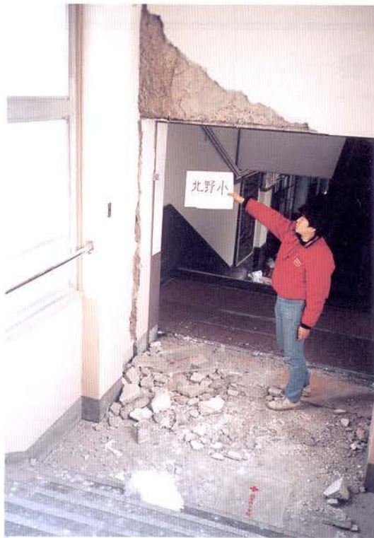
校舎増築部分柱亀裂
