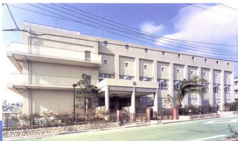
校舎全景 東側より撮影
