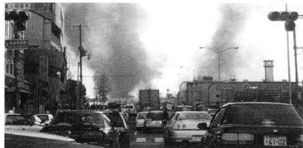
地震直後から市内各地で火災が発生し、幹線道路は大渋滞となった（1月17日 長田区付近）
