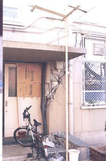
校舎出入口横柱せん断
