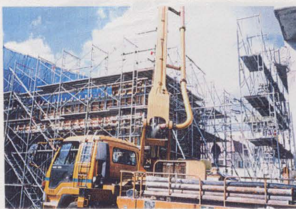
写真3.3.30 (図-3.1.4の 28) 阪急今津線跨線橋東側橋台修復状況
