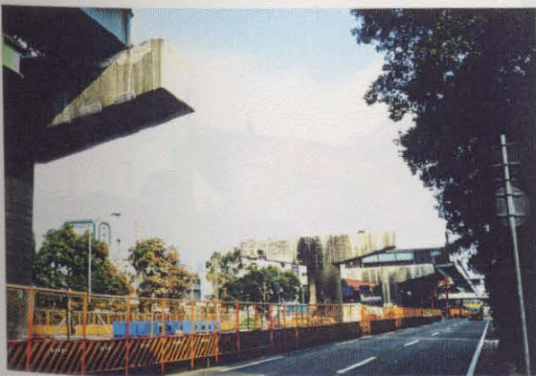
写真3.3.17 (図-3.1.4の 15) 西宮市馬場町の落橋部
