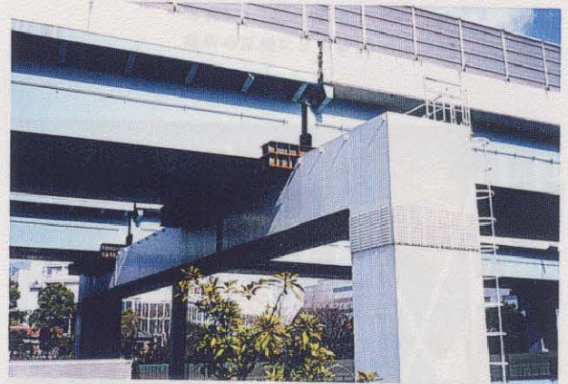
写真3.3.10 (図-3.1.4の8) ほとんどの鋼製は目立った変状は見られないが 桁は神戸方向にずれているものが多い。(第162橋脚)
