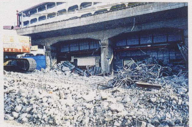
写真3.3.36 (図-3.1.4の 34) 阪急神戸線 門型高架橋の橋脚の座屈
