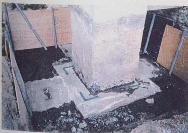
写真3.3.29 (図-3.1.4の 27) 高架橋支柱基礎部の7-フックと地中梁
