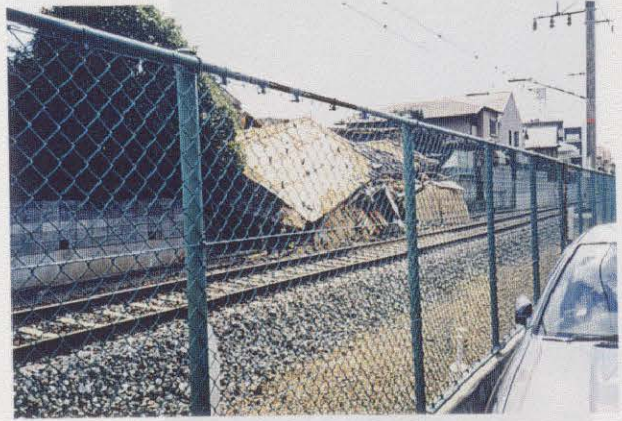
写真3.3.38 (図-3.1.4の 36) 阪急今津線 軌道の碎石が新しい。
