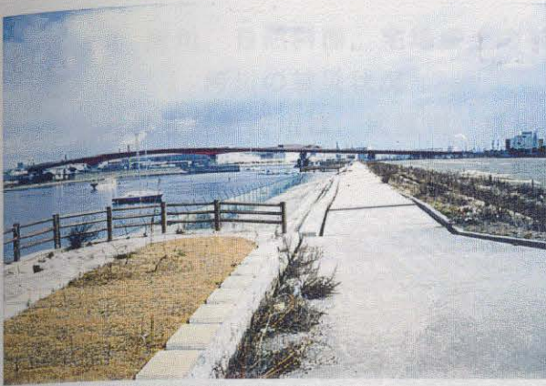
写真3.3.59(図-3.1.3の 15) 西宮浜 北側岸壁階段状護岸波打ち状態
