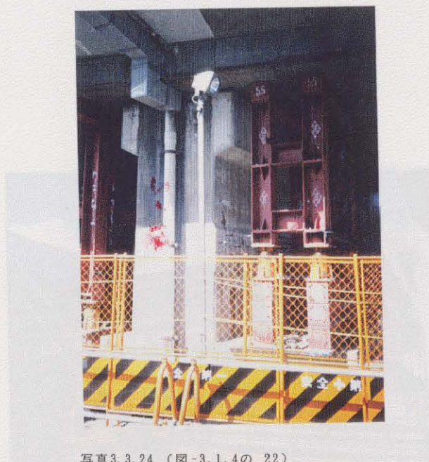
写真3.3.24 (図-3.1.4の 22) 橋脚の補強状況 H鋼とジャッキにより橋桁を支えている橋脚に アンカーボルトを設置し、橋脚断面を補強するための 工事が開始されている。
