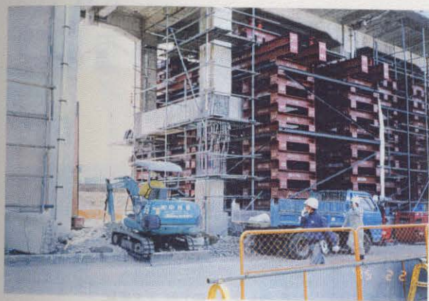
写真3.3.27 (図-3.1.4の 25) 支柱の補修状況
