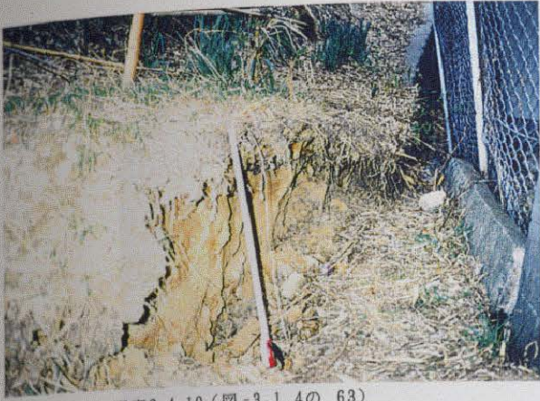
写真3.4.19(図-3.1.4の 63) 豊楽町付近 滑落崖(落差60cm)
