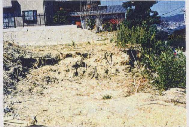
写真3.4.22(図-3.1.4の 66) 木津山町付近 滑落崖
