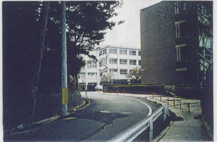
写真-3.2.13(図-3.1.1の㉔) 高座町14丁目 市立西宮高等学校 鉄筋コンクリート建築物 校舎が座屈し南側の 校舎が沈下する。
