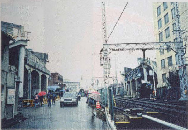
写真3.3.3 (図-3.1.4の1) 国道171号線 落橋
