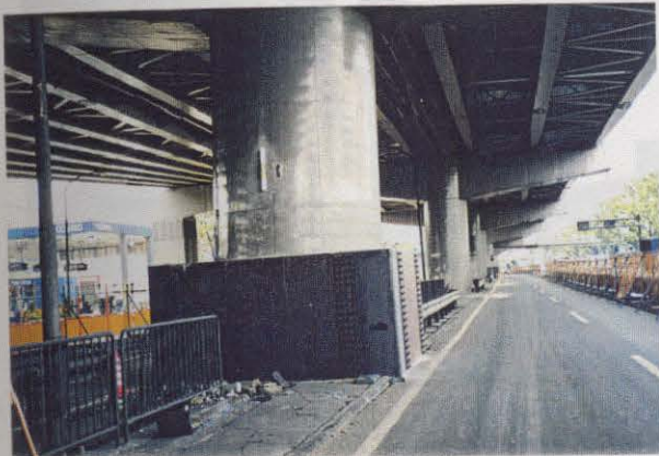
写真3.3.15 (図-3.1.4の 13) 橋脚被災部の補強工
