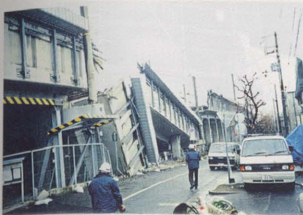
写真3.3.25 (図-3.1.4の 23) 新幹線 松籟荘付近 落橋
