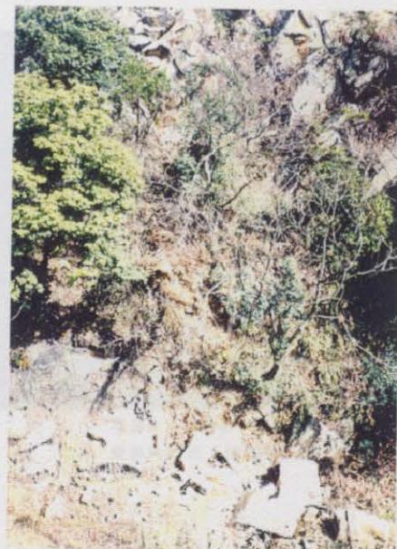
写真3.4.14 (図-3.1.4の 58) 夙川上流 小規模の崖崩れ
