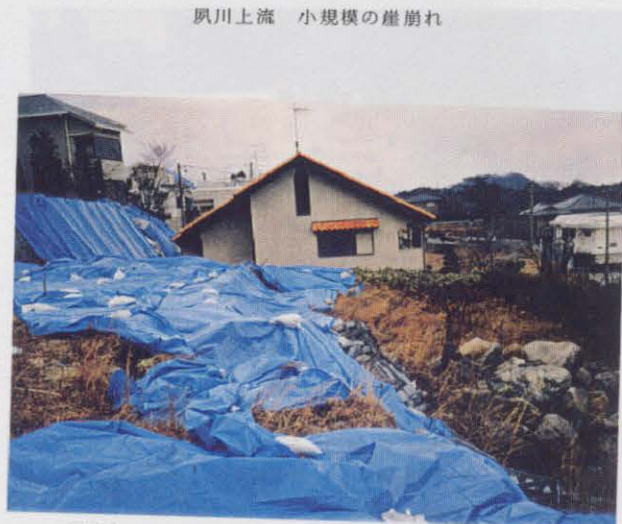
写真3.4.16 (図-3.1.4の 60) 剣谷町付近 (N 20 E、幅 20 cm~50 cm、落差 100 cm)
