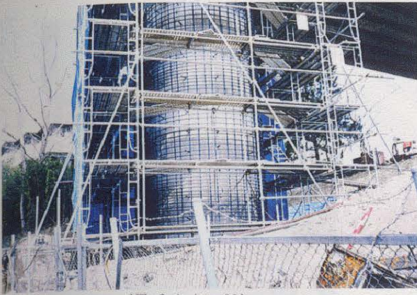
写真3.3.31 (図-3.1.4の 29) 武庫川右岸堤外側橋脚の補強工事の状況
