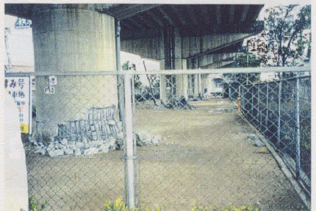
写真3.3.4 (図-3.1.4の2) 国道171号線 一脚型橋脚座屈
