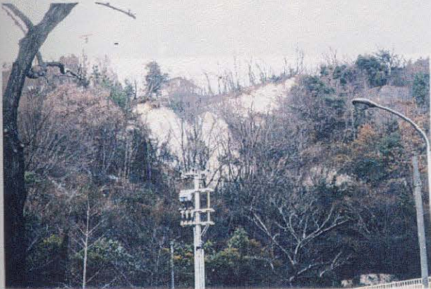
写真-6.4.11 鶴甲会館背面斜面の崩壊状況(図-6.4.9の③) 軟質の花崗岩が地すべりを起こしている。
