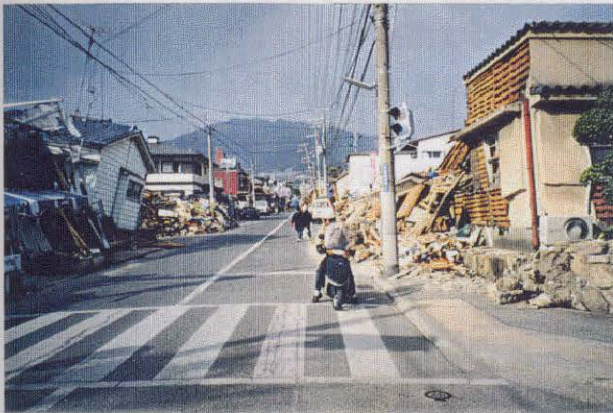
写真-6.2.16 六甲町2~3丁目(図-6.2.4の㉑) 木造家屋の倒壊が顕著である。
