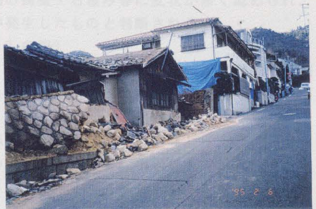
写真-6.2.19 上野通7丁目(図-6.2.4の㉒) 古い家屋は倒壊しているが、新しい家屋は被害が少ない。
