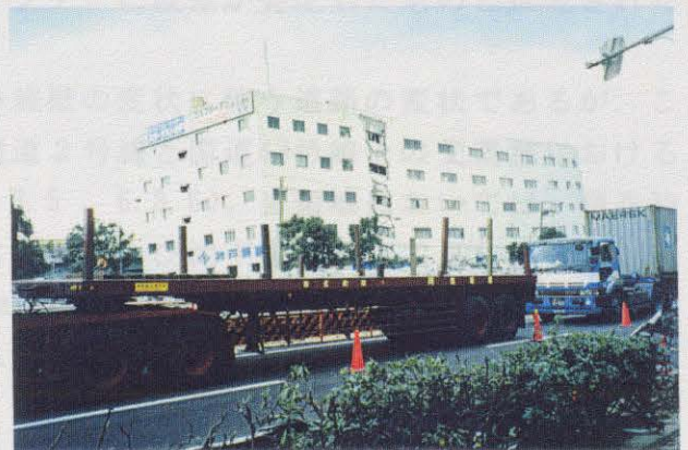
写真-6.2.20 岩屋中町1丁目(図-6.2.4の㉔) 神戸製鋼所、岩屋総合事務所。 右側の部分が被害大。
