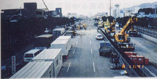
写真-6.3.7 岩屋陸橋の撤去後の状況(図-6.3.3の⑦)
