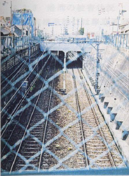
写真-6.3.19 阪神掘削部の状況(図-6.3.6の⑦) 岩屋北町三丁目 掘削部には異状が認められない。
