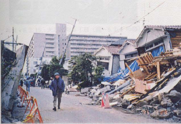
写真-6.2.9 高徳2丁目 (図-6.2.4 の㉖) 木造家屋は全壊状態である。
