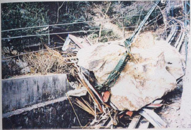
写真-6.4.10 同上・崩壊の下部の状況(図-6.4.9の②) 3m大の崩壊岩盤が六甲ケーブル下駅上の小屋を 破壊した。
