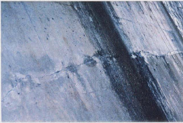
写真-6.4.5 都賀川・JR都賀川橋(図-6.4.3の⑤) 左岸側の橋台に横クラックが連続して入る。
