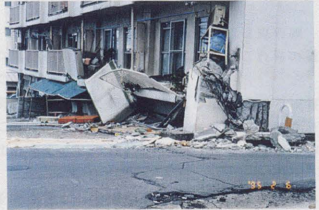
写真-6.2.18 澆南通1丁目(図-6.2.4の⑱) 大石川サニーハイツ。 1階部分が圧壊。
