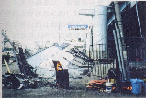
写真-6.3.8 非常駐車帯拡幅部の落橋(図-6.3.3の⑧) (阪神高速3号神戸線摩耶ランプ西500m)
