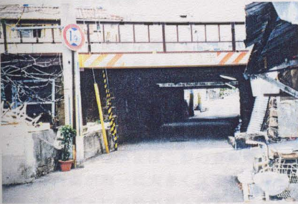
写真-6.3.20 阪急橋梁の状況(図-6.3.6の⑧) 福住町三丁目付近 健全
