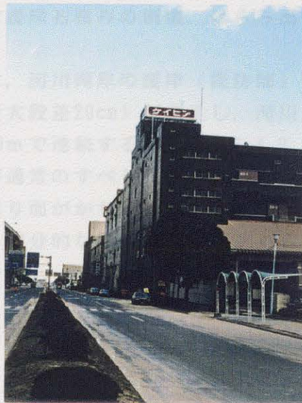
写真-6.3.36 摩耶埠頭 中央部道路(図-6.3.8の⑫) 大きな亀裂や陥没、不陸は生じていないが、噴砂 した砂はこの道路の全域で見られ、埠頭全体に 液化が生じたと思われる。
