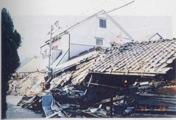
写真-6.2.1 友田町2丁目の木造家屋の被害状況(図-6.2.4の①) 古い木造家屋は全壊状態であるが、新しい家屋は 損傷が軽微である。
