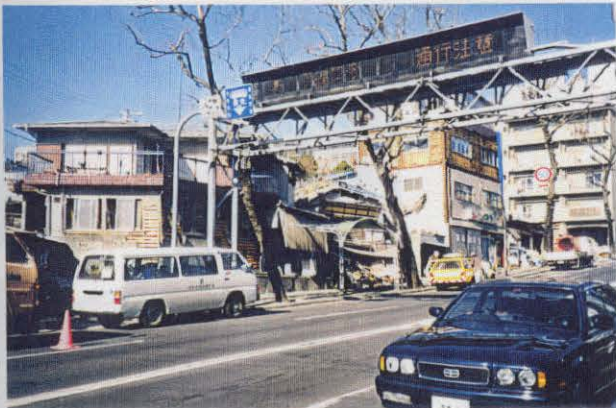
写真-6.2.3 寺口町東部の家屋の被害状況(図-6.2.4の③) 石屋川沿いの沖積層分布域に位置し、古い木造家屋 は半壊~全壊状態である。
