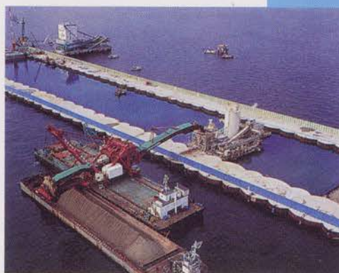
◆東京湾横断道路木更津人工島東工事
