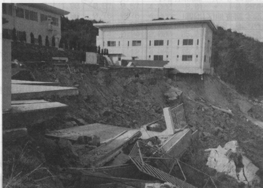
写真5.1.2-2 崩壊頂部のRC建築物
