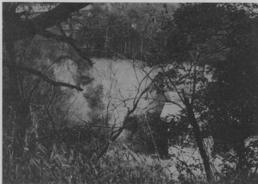
写真5.1.2-5 丘陵部の宅地地盤の斜面崩壊
