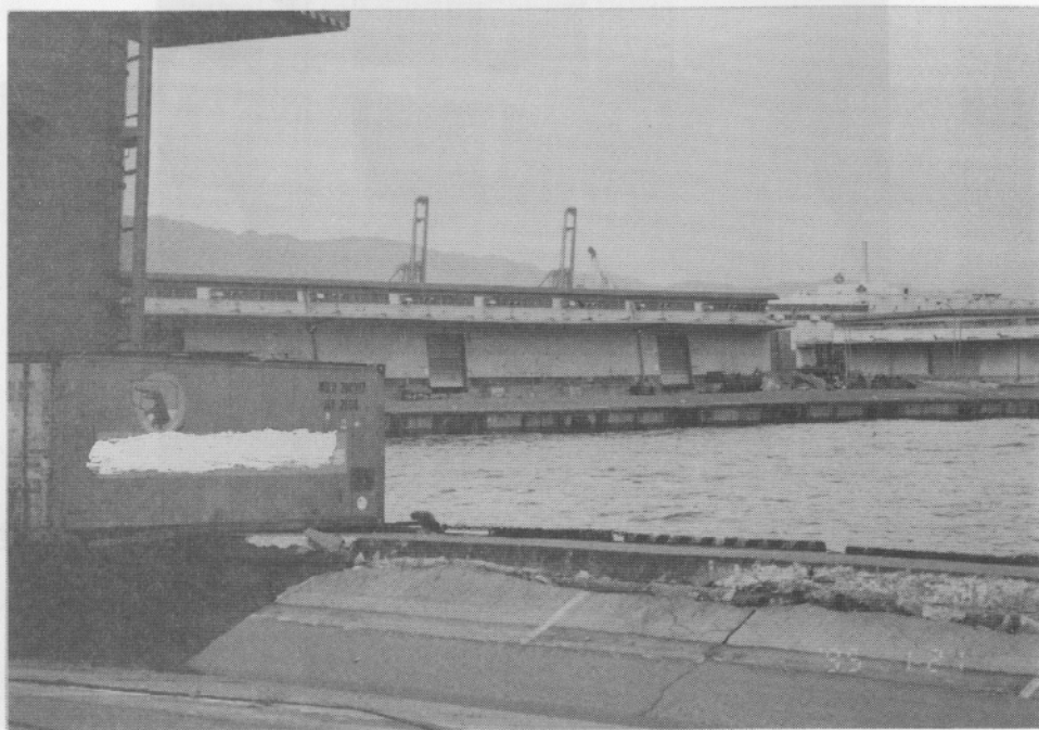
写真5. 2. 5-12 地盤の液状化によって傾斜した護岸付近の倉庫
