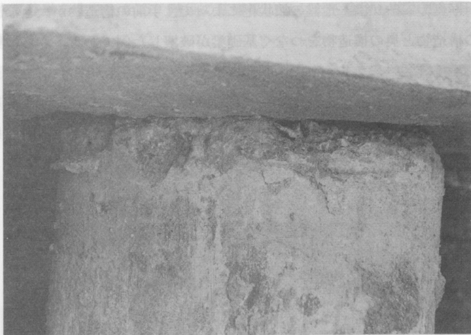
写真5. 2. 5-11 液状化に起因する地盤の側方流動および地盤沈下によって露出した杭頭部
