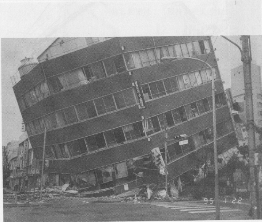
(b) 下層の崩壊（6階建てRC造，1,2階部分が崩壊）
