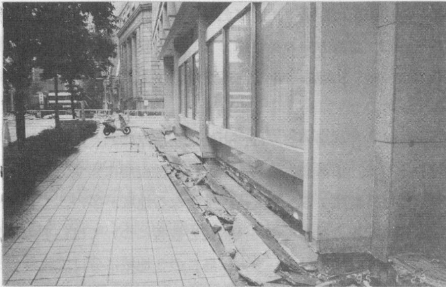
写真5.2.5-1 建物外周部の地盤面の状況
