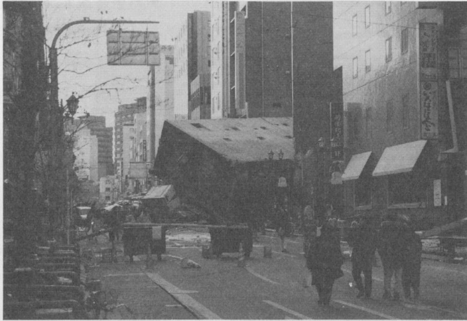
(a) 建物全体の転倒
