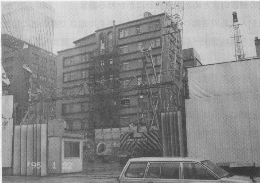
写真5.2.5-15 地震時に連続地中壁を施工中の工事場
