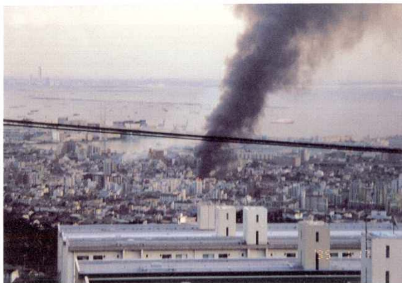
写真-01 高台より東灘区の青木・魚崎を見る (95. 1. 17本震災直後、写真-05 まで同じ)
