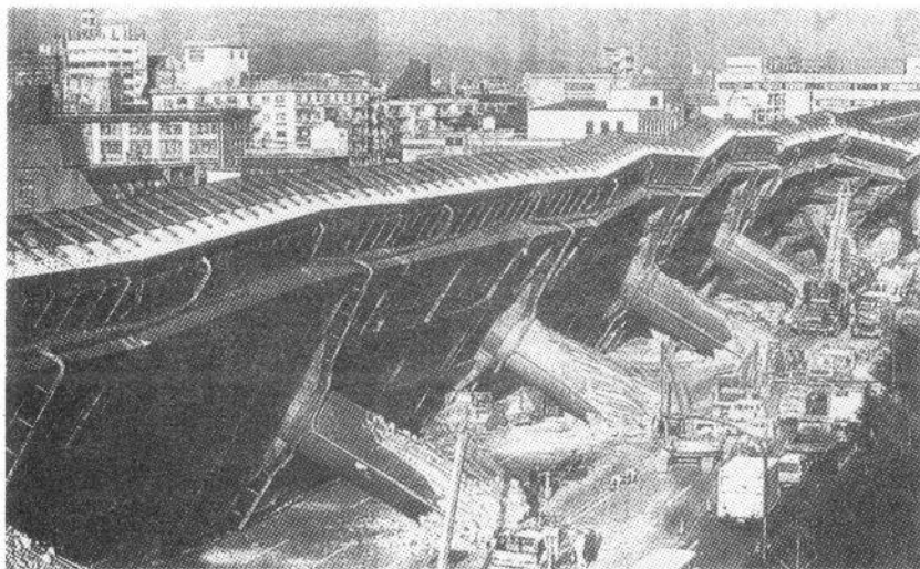
写真-2.1 東灘区深江において延長635mにわたって転倒した高速道路 (神戸新聞, 95. 2. 23)
