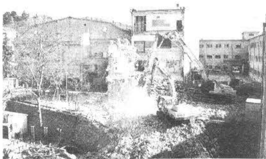
中館（西部分）・プールの解体作業（2月11日）
