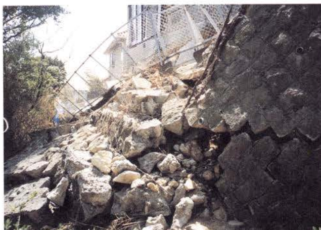
被災状況（住吉山手8丁目の民間宅地擁壁の崩壊：神戸市東灘区）
