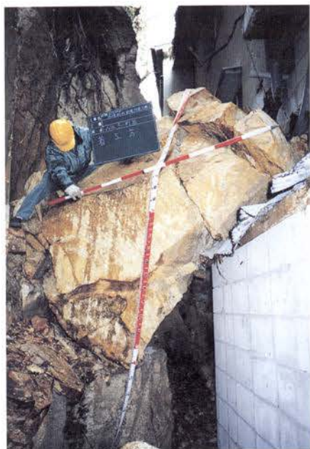
被災状況（塩屋地区の落石：神戸市垂水区）
