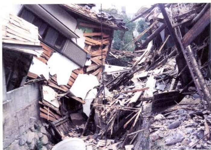
倒壊家屋が河道を閉塞
