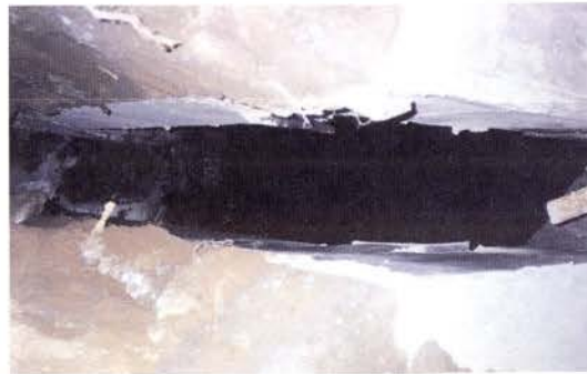
写真4 西谷川 (甲第276号、中央区脇浜海岸通) 目地が大きく開いている
