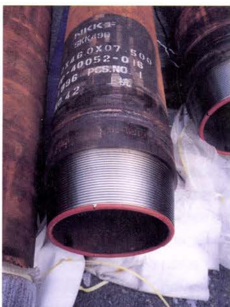
写真5 Bブロック鋼管杭(ねじ継手)
