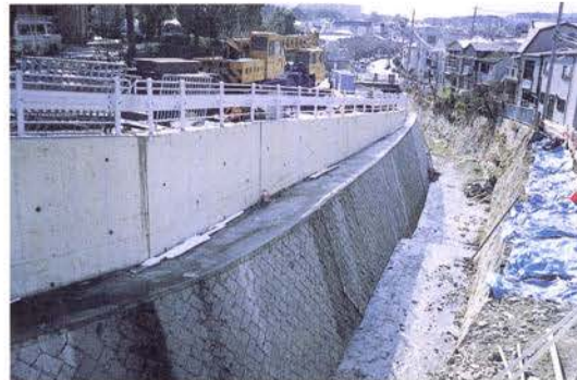
写真4 施工状況 (左岸側は完成、右岸側は土留仮設工法の検討を行い着手)
