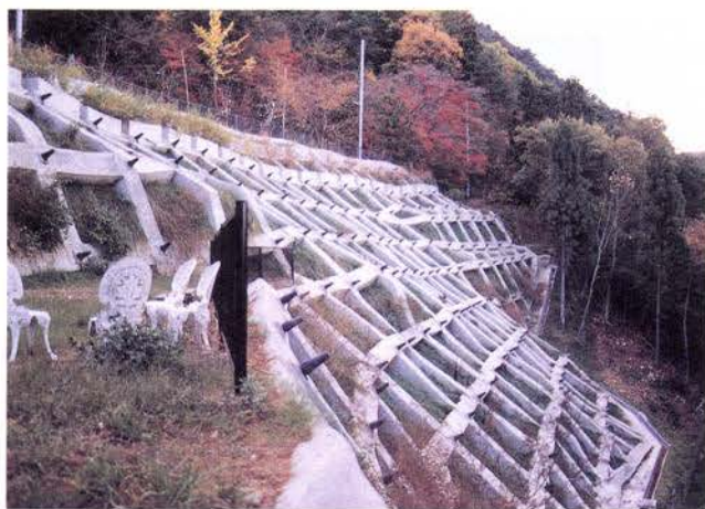
写真4 完成状況 (Aブロック：アンカー工併用吹付け砕工)
