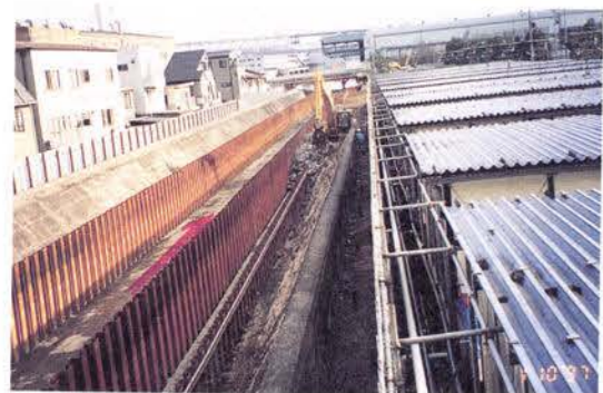
写真2 復旧状況（河口部）
