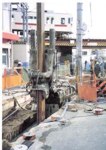
写真4 鋼矢板打設状況 (A, B, Cブロック)
