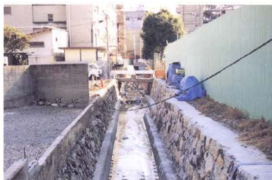
写真2 復旧状況 (甲第31号)
