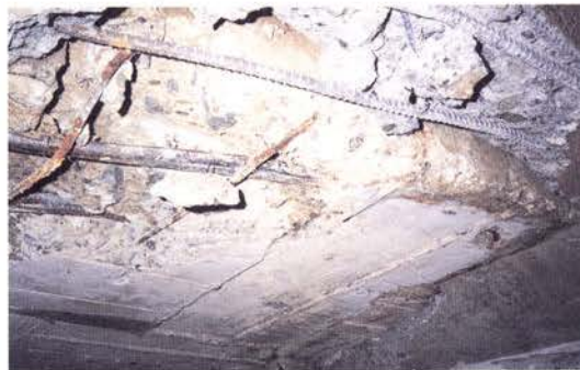
写真2 西瀬川 (甲第94号、東灘区住吉南町)
