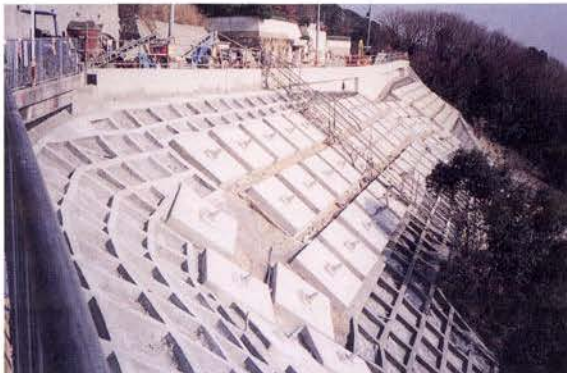
写真5 施工状況 (B-1・2ブロック)
