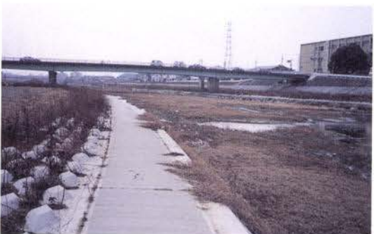
写真4 復旧状況 (甲第215号)
