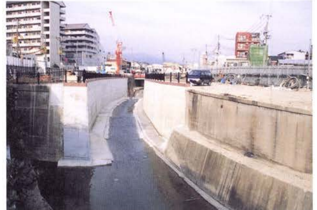
写真6 完成状況(下流工区: 刈藻川合流点)
