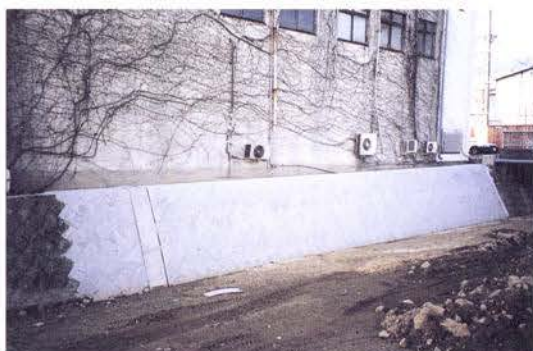
写真2 復旧状況 (右岸)
