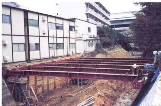
写真4 施工状況 (切梁による土留工で建物防護)
