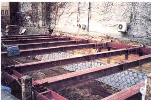
写真3 施工状況 (切梁による土留工で建物防護)
