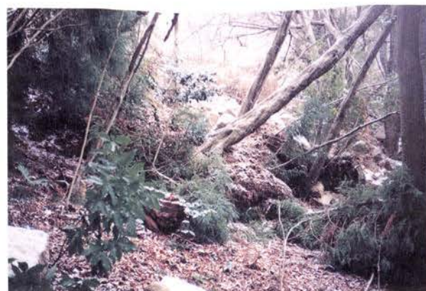
写真2 被災状況 (Bブロック：簡易保険保養センター)
