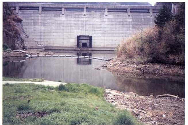
写真2 水位低下状況(天王ダム上流面)
