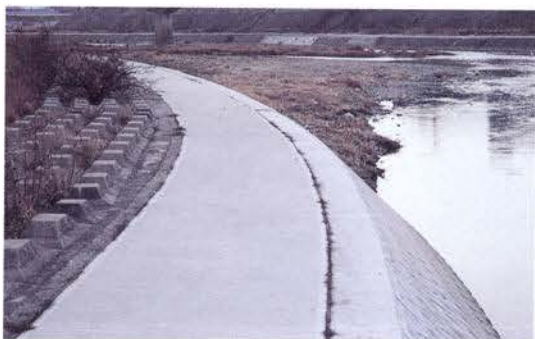
写真2 復旧状況 (甲第212号)
