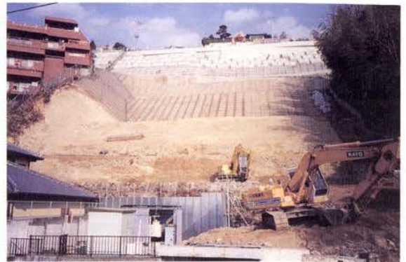
写真6 施工状況 (Fブロック)
