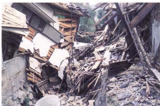
写真1 被災状況 (甲第31号)
