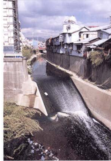
写真5 着工前(下流工区: 刈藻川合流点)
