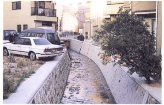
写真2 復旧状況 (上流部)
