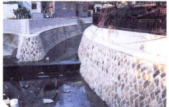
写真4 復旧状況 (下流部)
