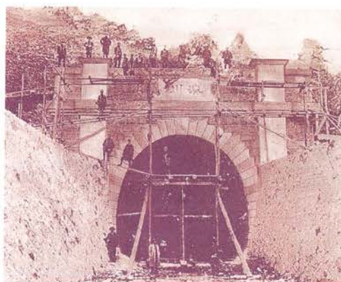
写真2 会下山トンネル（施工時）
