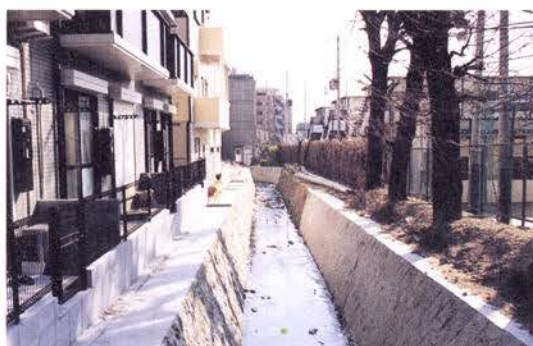
写真4 復旧状況 (甲第34号)
