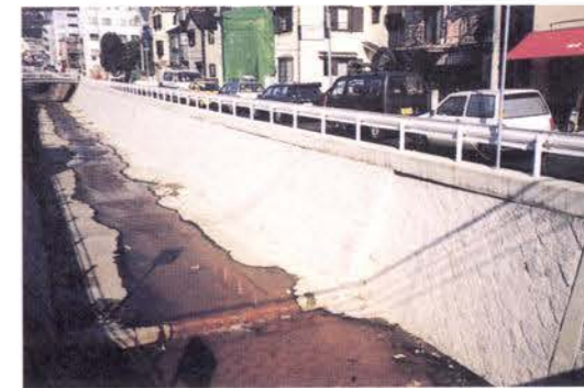
写真2 復旧状況（下流部）
