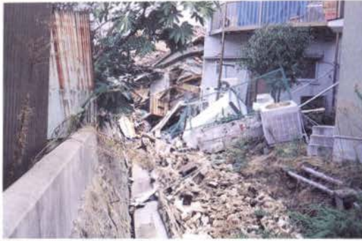
写真1 被災状況 (上流部)
