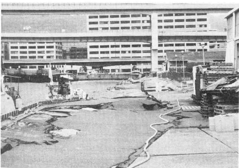
④⑩第1突堤西側岸壁。
