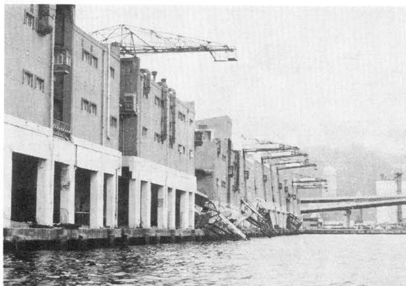
⑤④上部から崩落したクレーン。
