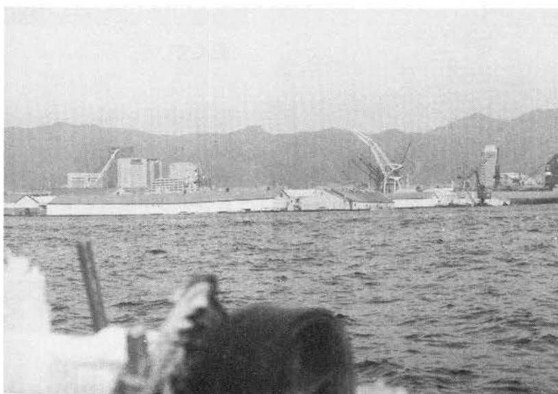
②8兵庫空堤。左から屋根の倉庫が歪み、中央屋根の倉庫と右方のクレーンが水没している。
