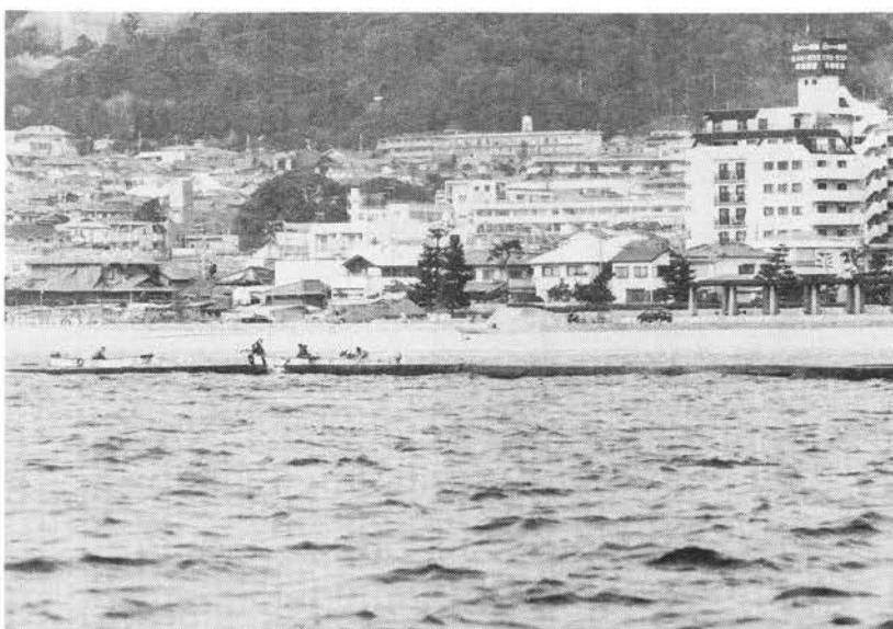
②③須磨人工海浜の離岸堤。これも相当沈下した様子。
