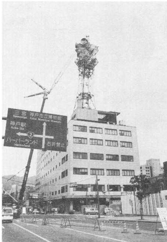
④NTTの鉄塔も傾いて、クレーンで倒壊を止めている。同ビル左下の道路はもちろん通行止め。
