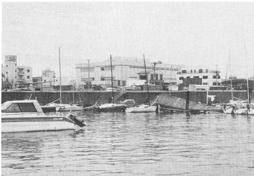
⑦西宮港奥のヨットハーバー。 浮棧橋もめくれあがっている。
