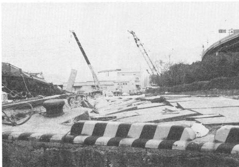
⑤⑨陸上は他所と同じく陥没。
