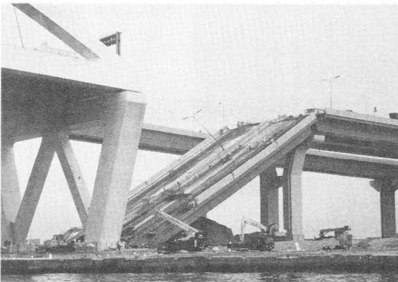
⑥8西宮大橋。完全落下した道 路。
