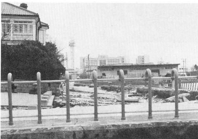
④⑦同前。内側の陥没の様子。
