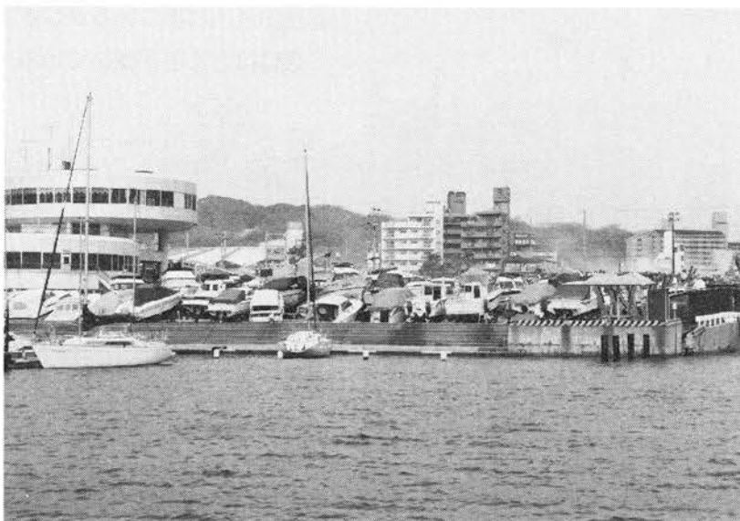
②⑤須磨のヨットハーバー。階 段護岸の内側が陥没してい るため、船が船尾を下方に 向けている。
