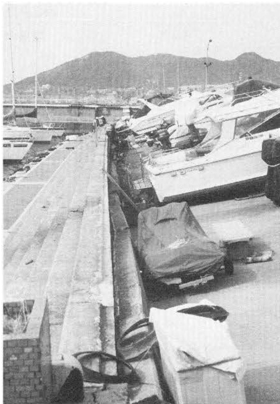
②7同前。階段奥は陥没し、クルーザーはすべて傾いている。
