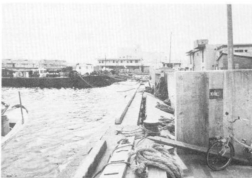
③③七宮町。護岸は海から見ると何でもないが、内側の陥没はひどい。
