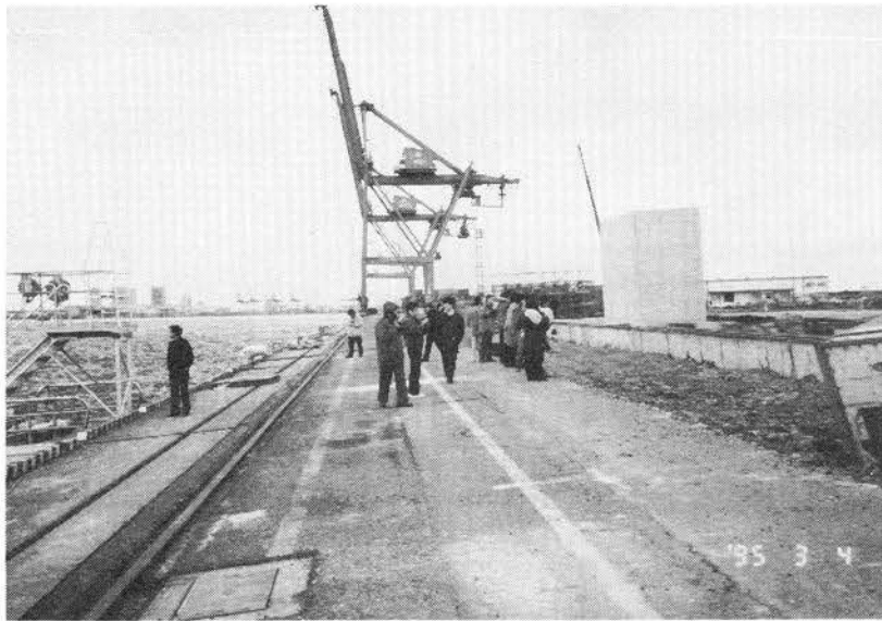
⑫同前内側の陥没がひどい。 (3/4 視察時)。
