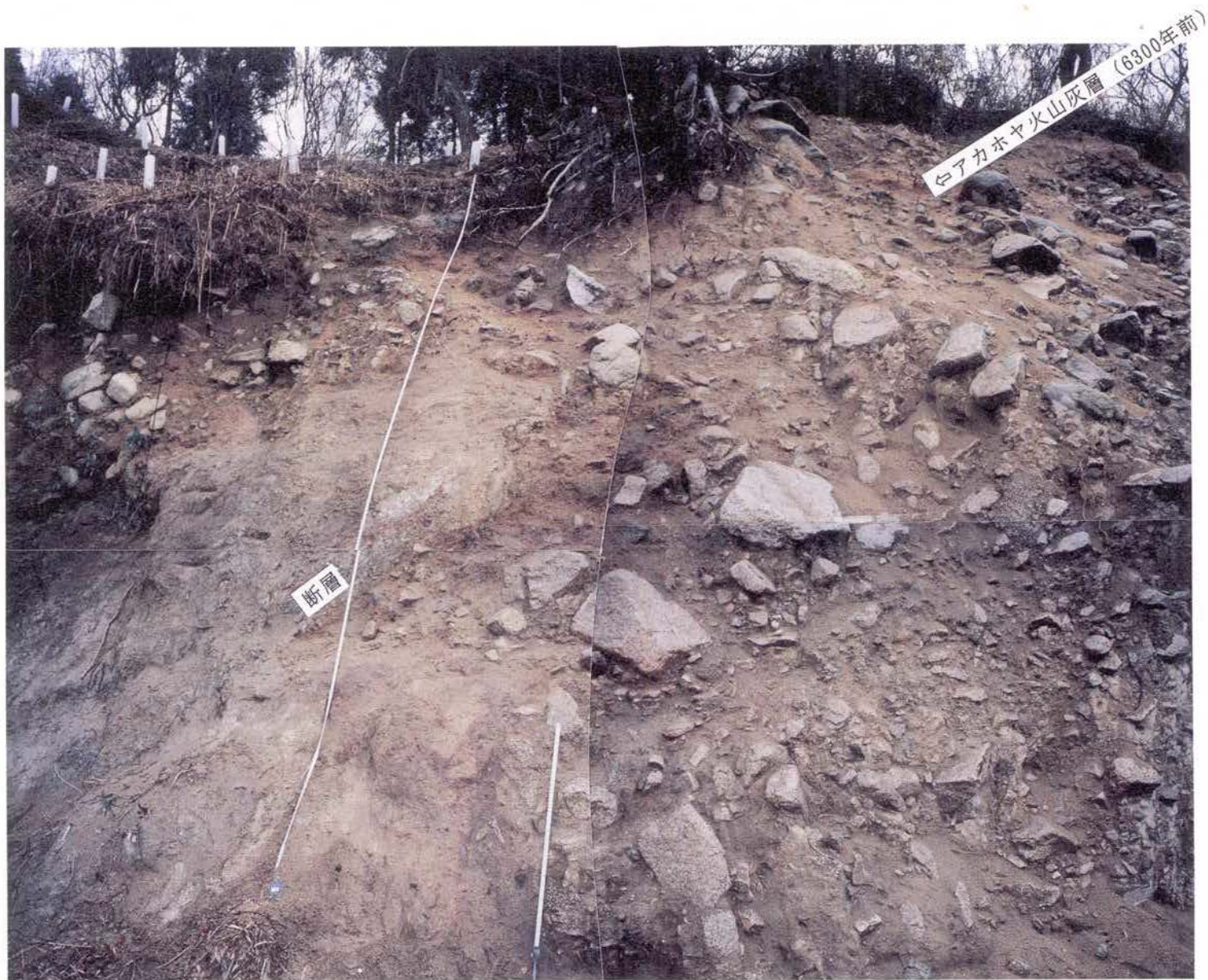
図-2.2.30 西滝ヶ谷地点露頭断層近傍の状況
