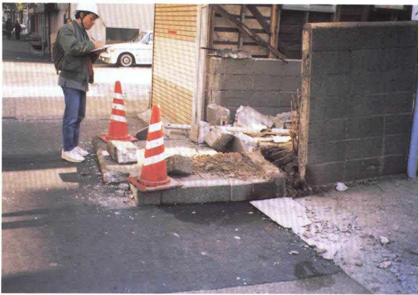
応急危険度判定を する建築士（神戸市内）
