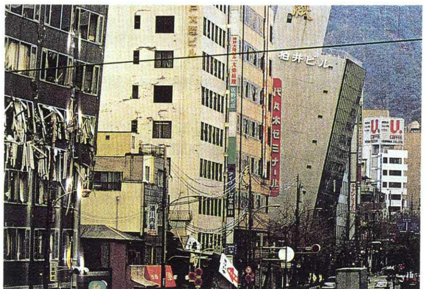
中高層建築物 の倒壊 （神戸市内・三宮周辺）
