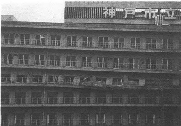
(写真-3) 中間階破壊(神戸市内)
