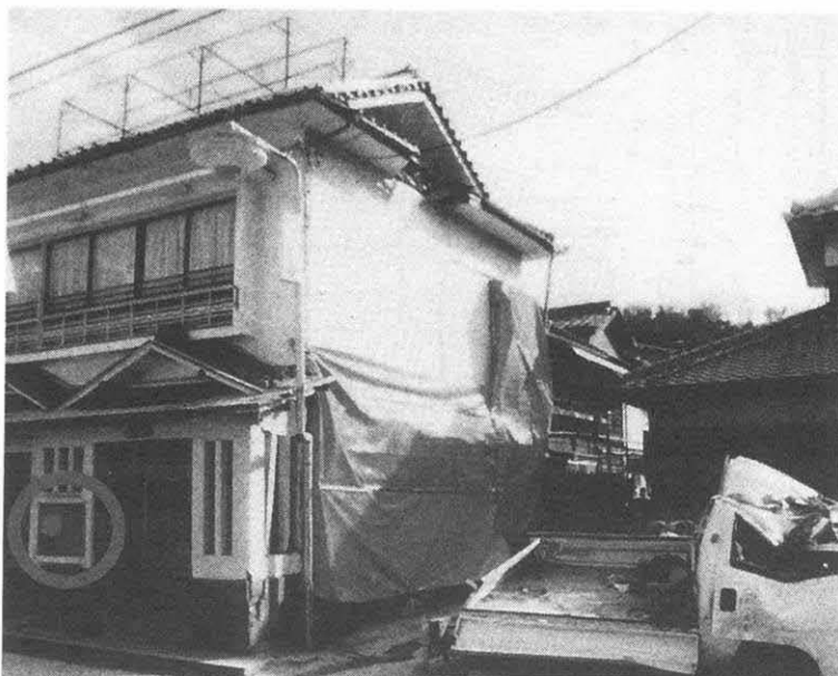
危険—使用不可 (赤シール) を貼った家屋 北淡町富島地区
