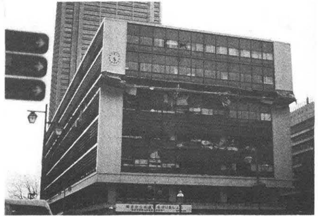
(写真-2) 中間階破壊(神戸市内)
