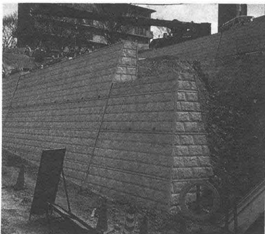
施工中の状況
