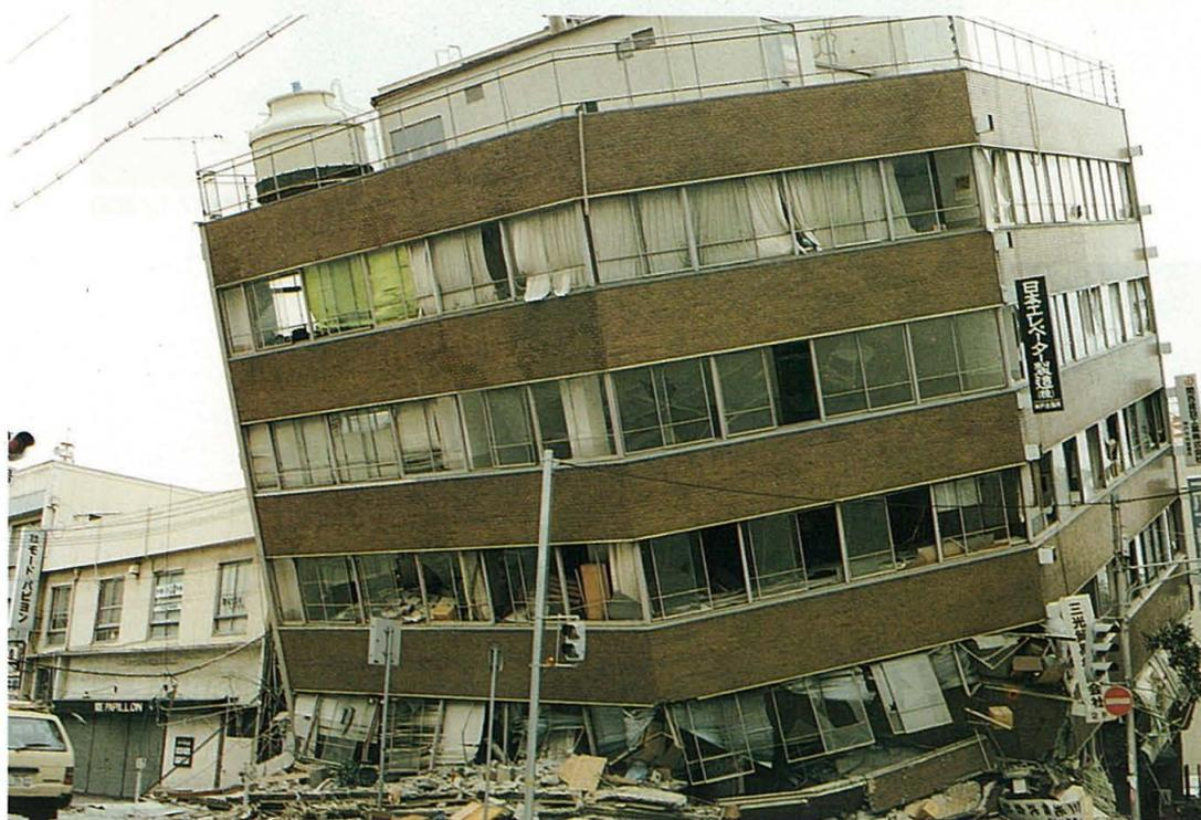
1階部分が崩れ大きく傾いたビル (H7.1.18/中央区)
