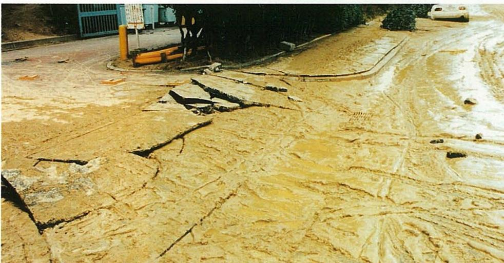
液状化現象により泥水が噴出した道路
