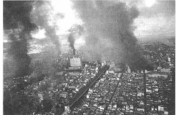
写真2-4-1 市内各所で発生した火災
