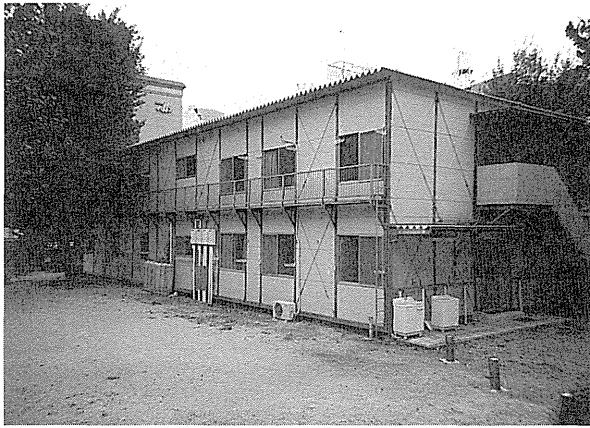
写真6-2-3 地域型仮設（生田町公園／中央区） 〔写真提供：大和工商リース㈱〕
