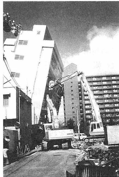
写真7-2-2 倒壊家屋の解体(RC造)
