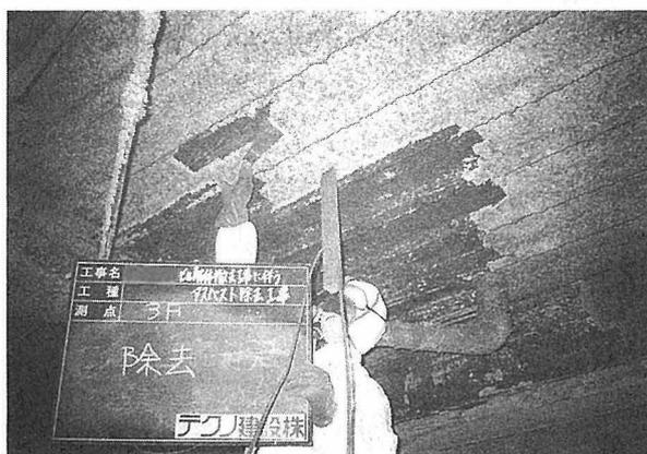
写真7-3-1 アスベストの除去作業
