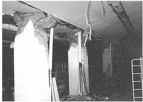
写真10-3-2 同上 1階柱頭部圧壊
