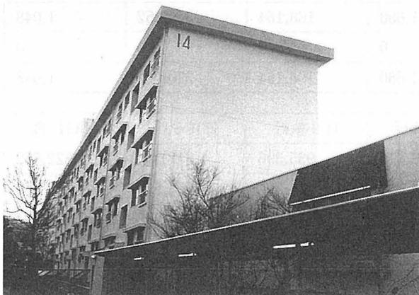
写真10-3-1 渦森団地14号館被災状況(建物が4度近く南に傾く)
