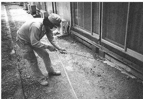
写真12-3-2 仮設住宅床下の薬剤散布（須磨区）
