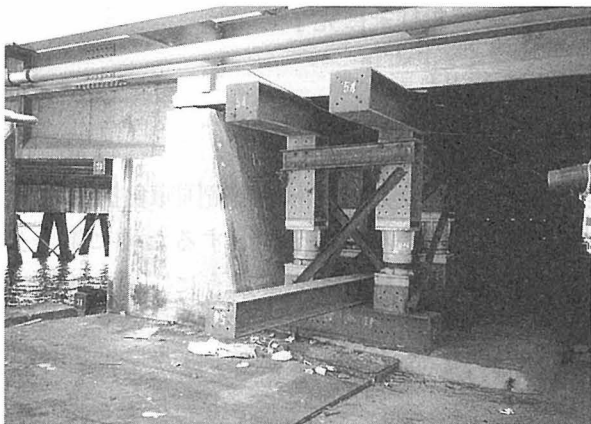
写真19-1-1 深江大橋補強
