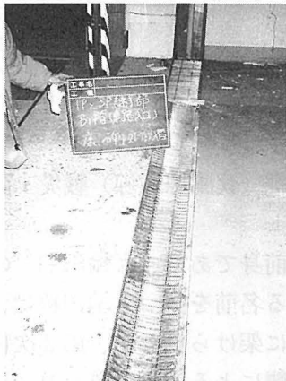
写真19-1-4 第1駐車場と第3駐車場の間のジョイント部の水平変位（10mmの広がり）
