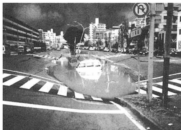
写真19-5-13 国道28号の陥没状況
