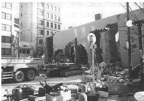
写真19-1-2 倒壊ビル撤去作業
