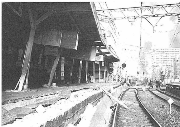
写真19-5-9 板宿駅の被災状況
