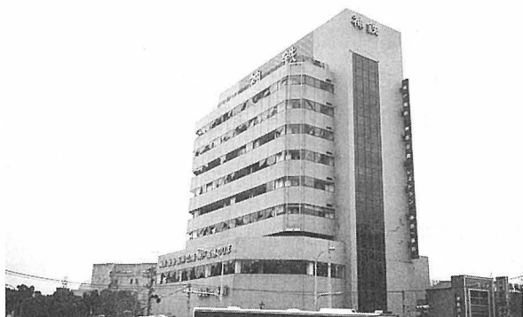
写真19-5-7 本社ビルの被災
