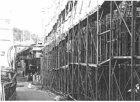
写真19-5-10 塩屋高架下工事
