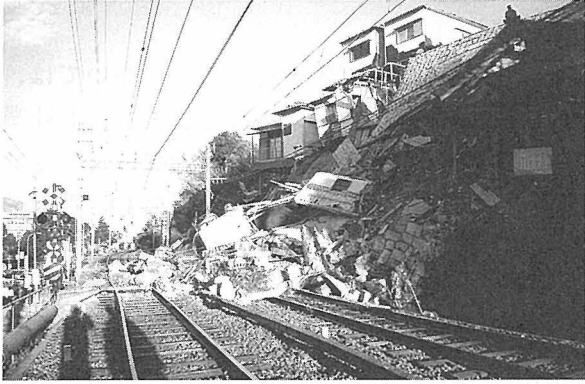
写真19-5-5 被災した法面（湊川～長田間0 K 780 M 付近）
